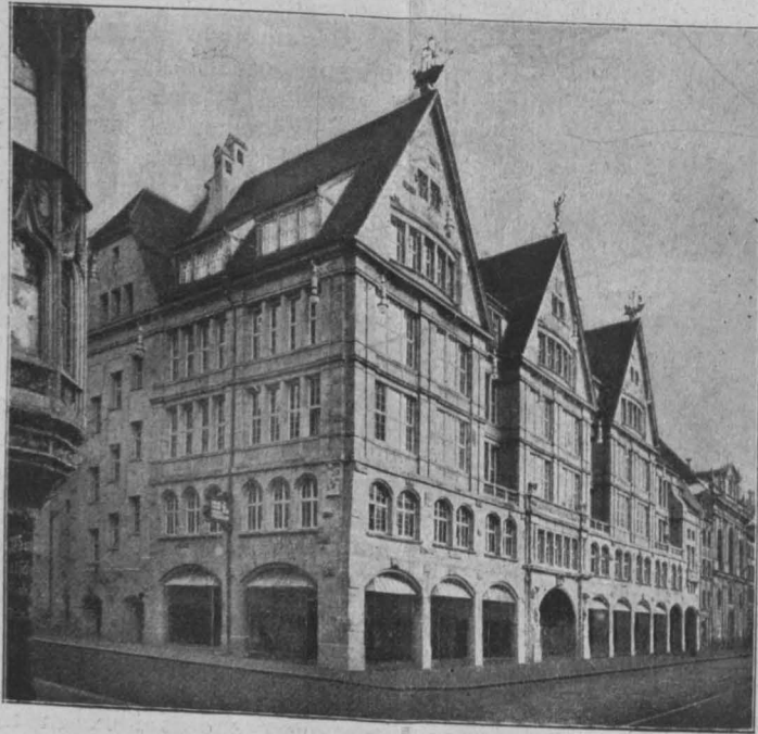
Abb. 10 Kaufhaus Emden (Oberpollinger) Mit gefälliger Erlaubnis der Deutschen Bauzeitung
