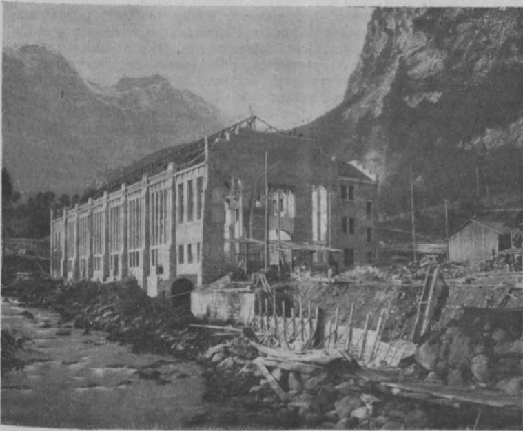
Abb. 11 Zentrale der Löntschwerke
