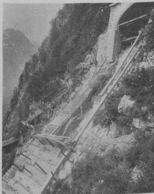
Abb. 10 Anlage der Druckrohrleitung
