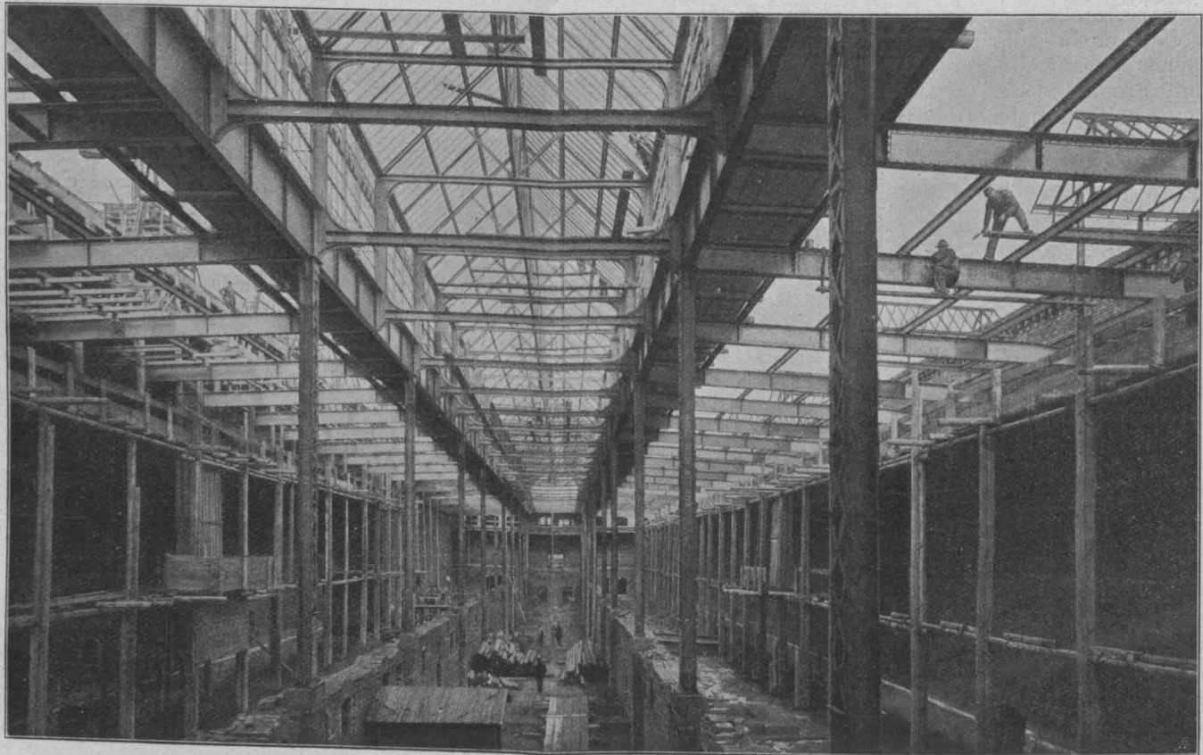
Abb. 9. Eisenkonstruktion des Kesselhauses.
