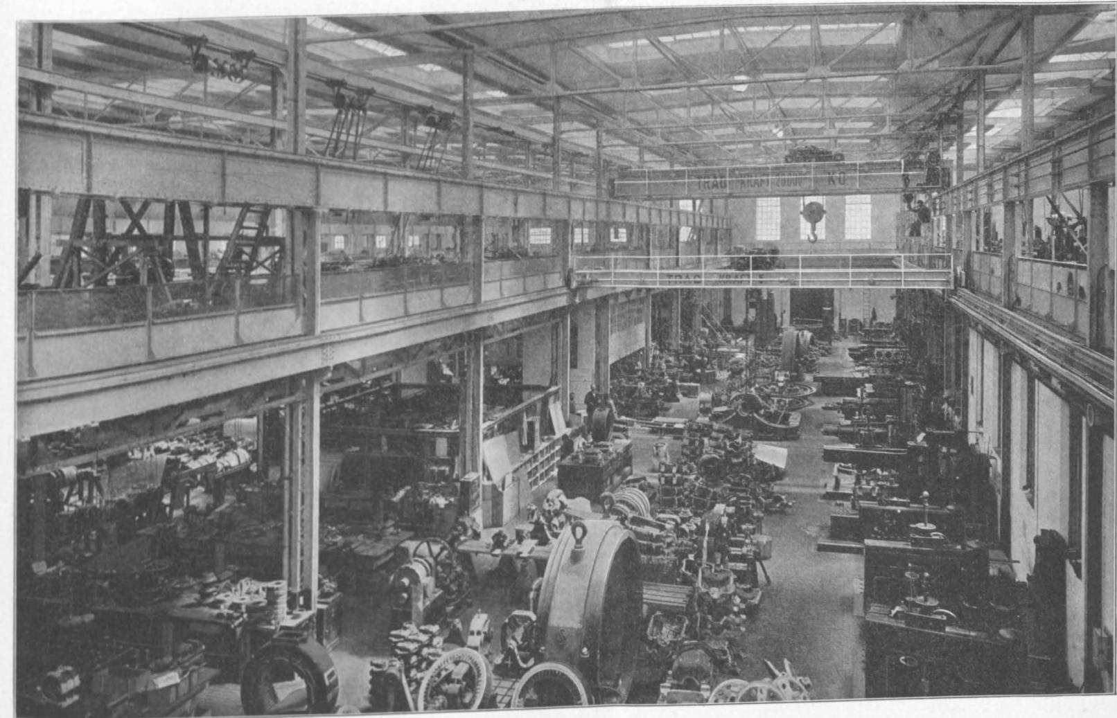
Elektrische Laufkräne in den Leopoldauer Werkstätten der Siemens & Halske A.-G.
