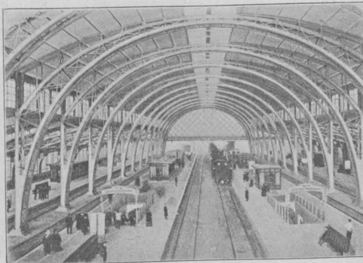
Fig. 9. Neustädter Bahnhof: Innenansicht der eisernen Halle.
