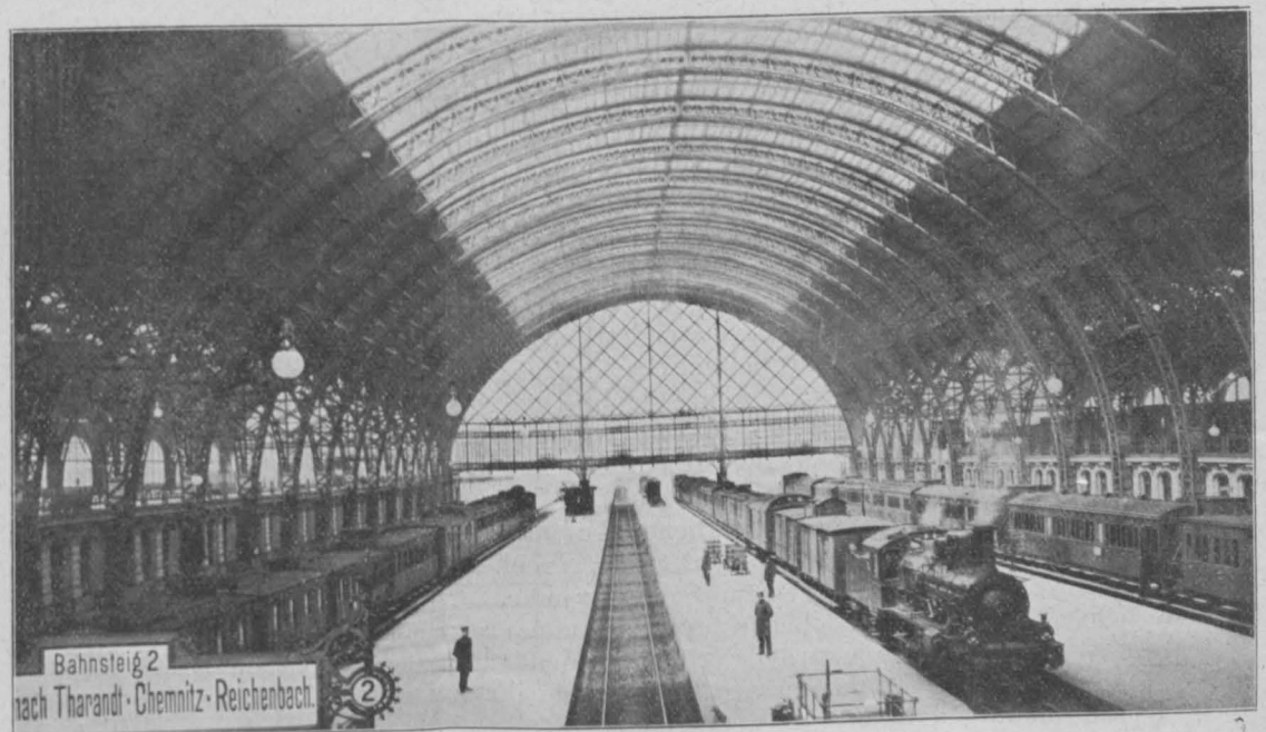
Fig. 7. Hauptbahnhof: Innenansicht der eisernen Hallen.
