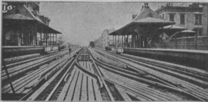
Fig. 12. Strecke mit dritter Schiene.
