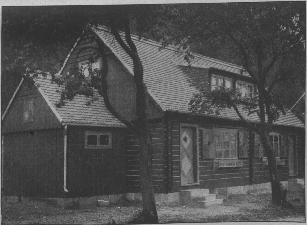
Blockhausbauten von Adolf Sommerfeld in Berlin.
