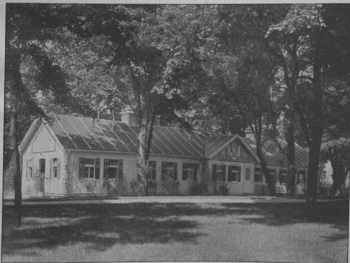
Zerlegbarer Kranken-Pavillon, System Doecker, in Regensburg. Ausgeführt von Christoph & Unmack in Niesky in der Ober-Lausitz.
