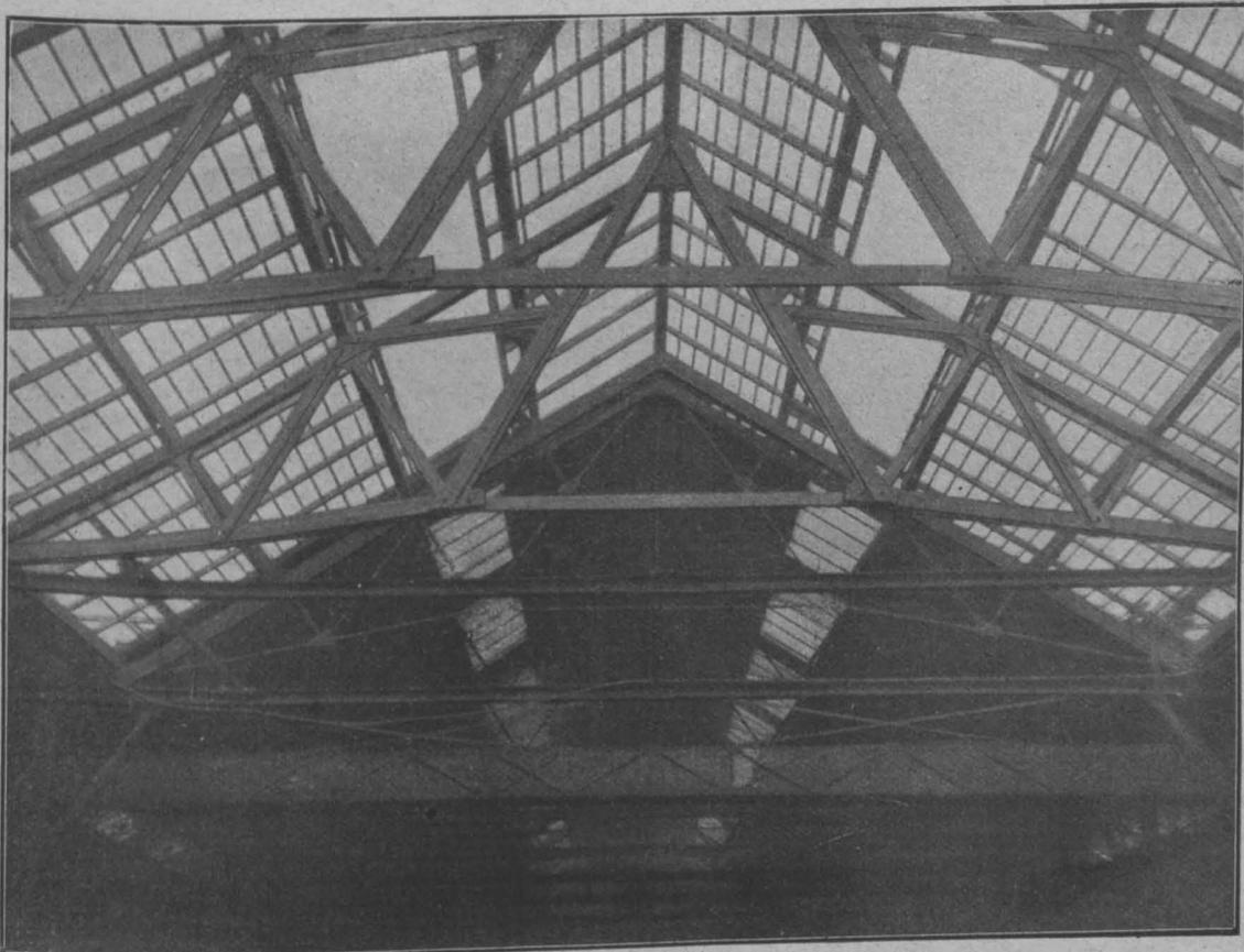
Abbildung 11. Dachkonstruktion mit Anwendung von Ringdübeln System „Tuchscherer“.
