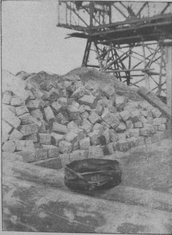
Abbildung 8. Beim Rammen zusammengestauchtes Blechrohr.
