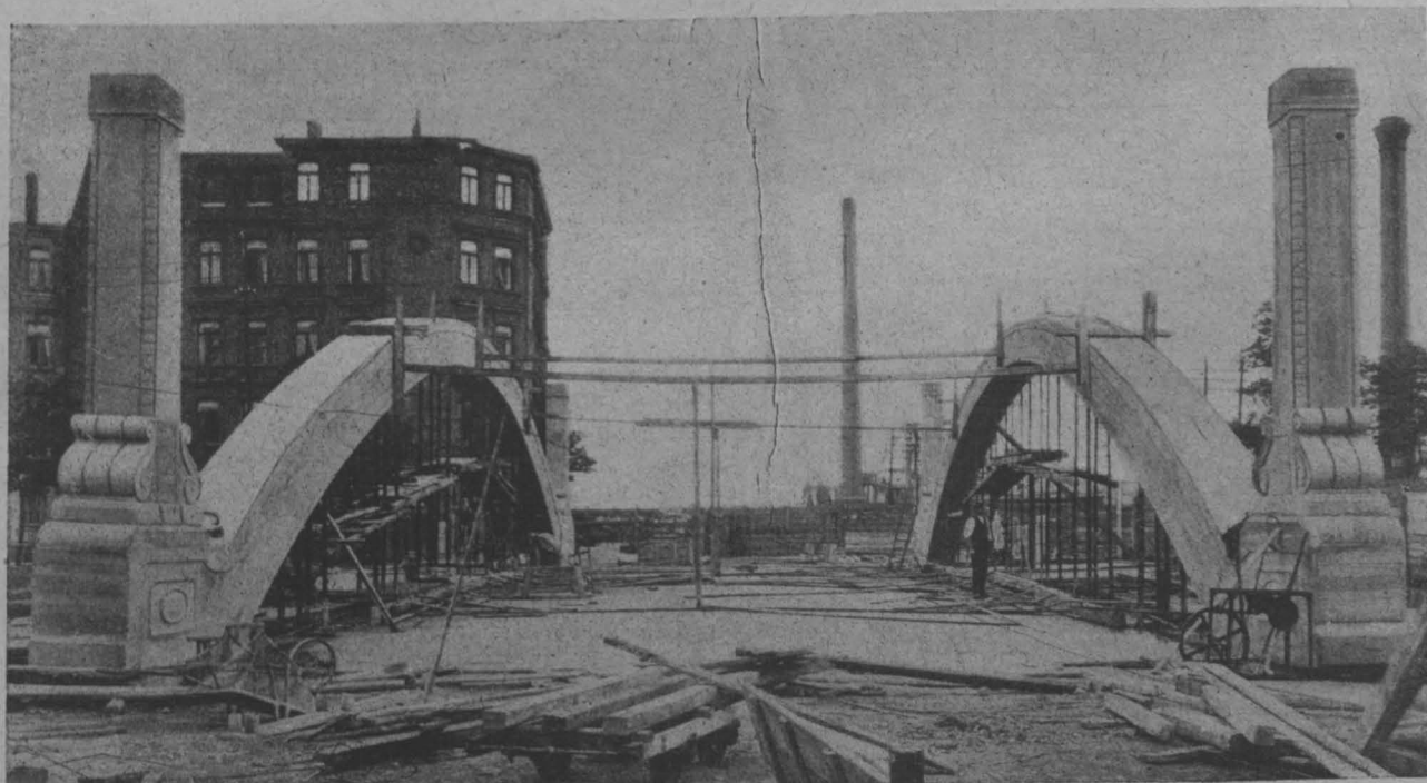
Abbildung 7. Blick auf die Brücke während der Herstellung.
