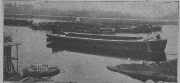
Abbildung 3. Seeleichter von 250 t Tragkraft.
