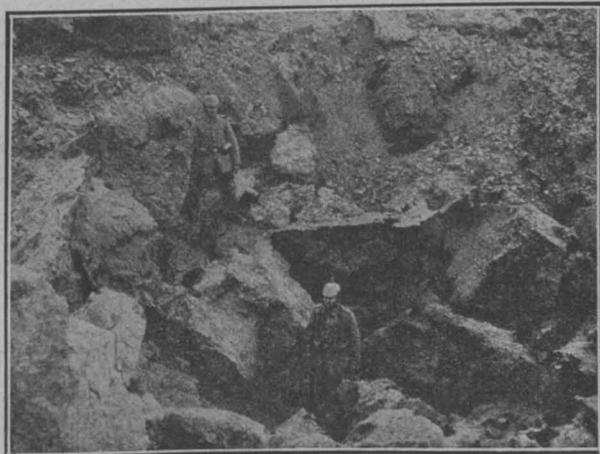
Abbildung 12. Durch Beschießung mit schwerem Geschütz zerstörtes Betonmauerwerk (ohne Eiseneinlagen) eines Forts.
