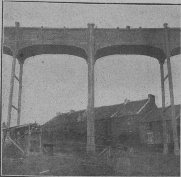
Abbildung 6. Viadukt zu 5 mit Ausdehnungsfuge.
