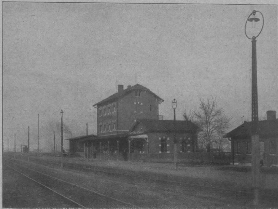
Abbildung 2. Mast für Glühlampen-Beleuchtung (Eisenbahn-Direktion Nürnberg).
