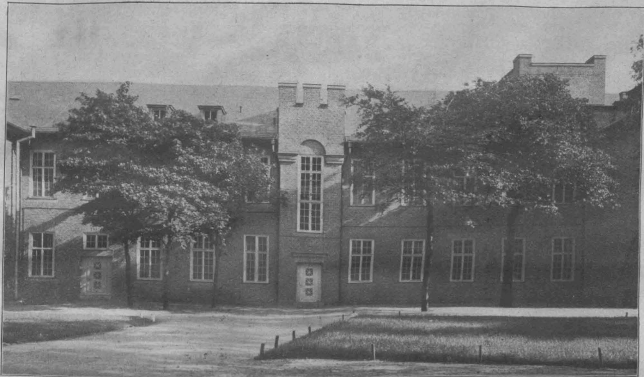
Wirtschaftsgebäude des städtischen Krankenhauses in Altona a. E. (Waschküche). Arch.: Boethke & Schmieden in Berlin.
