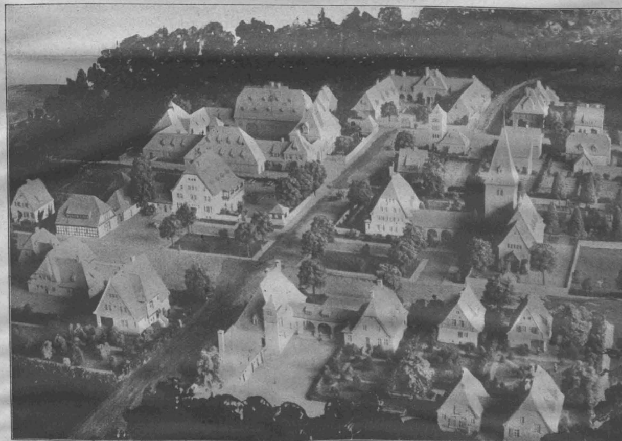
Die Zukunft der kriegsbeschädigten Bauhandwerker. Ein Dorf für Ostpreußen. Der Kirchplatz und Gesamtansicht.
