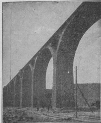
Viadukt im Stambecken der Mohnetalsperre bei Detlecke, Länge 450 m, Höhe 30 m.
