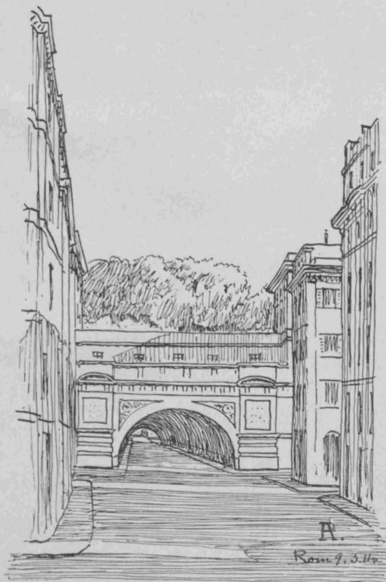
Straßen-Tunnel Umberto I. in Rom,
