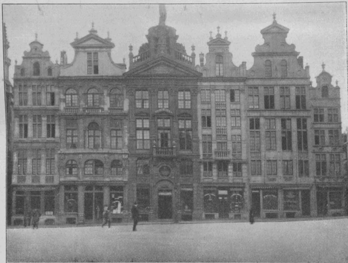
Nordostseite des Marktplatzes in Brüssel. Aufnahmen von Reg.-Bmstr. G. Marstatt in Köln. Erhaltung der Kunstdenkmäler in Belgien.
