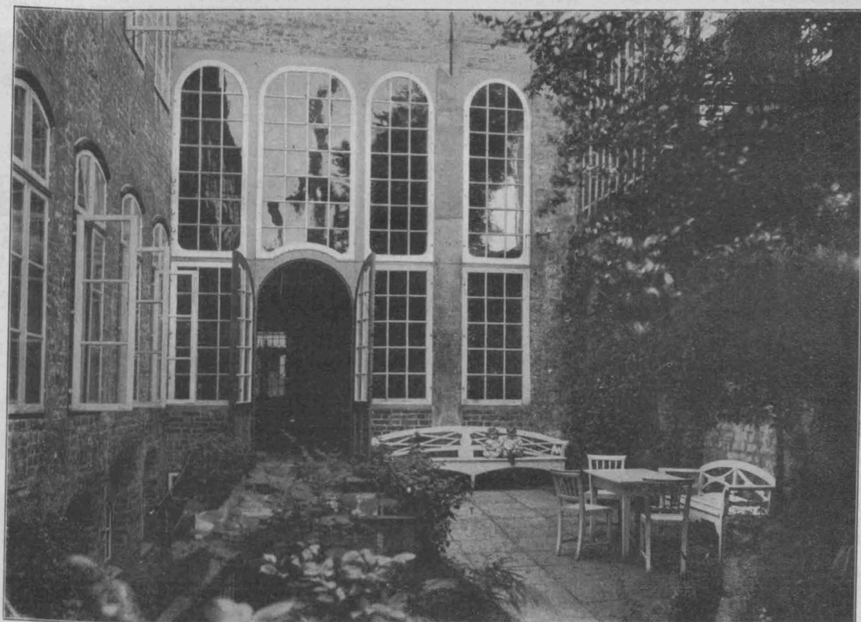
Ansicht des Hof-Ausganges des Vorderhauses. Das wiederhergestellte Schabbel-Haus in Lübeck.
