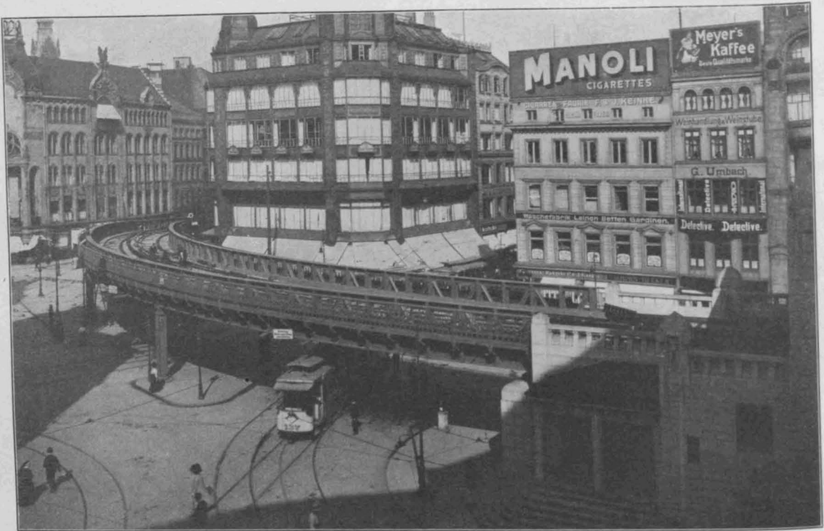
Abbildung 41. Gekrümmter Viadukt zwischen Haltestelle Rödingsmarkt und Mönkedammfleth.
