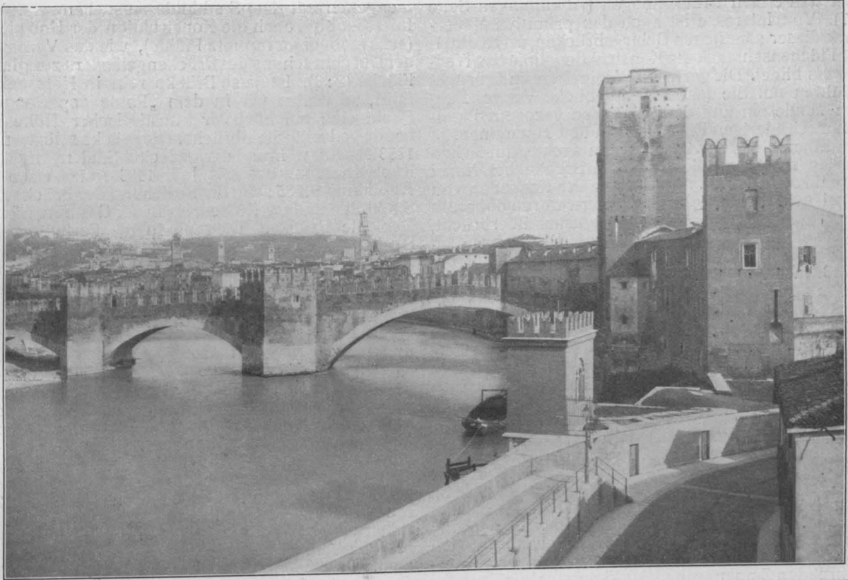
Befestigte Etsch-Brücke des Castel Vecchio in Verona. (Erbaut 1355–1358.)
