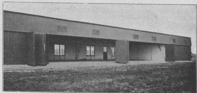
Falttor mit Kantenführung (Stephansdach, G. m. b. H., Düsseldorf).
