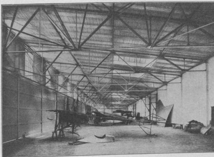
Innenansicht einer Flugzeughalle mit 5 Feldern in Eisen (Ausführung D. Hirsch, Berlin-Lichtenberg).
