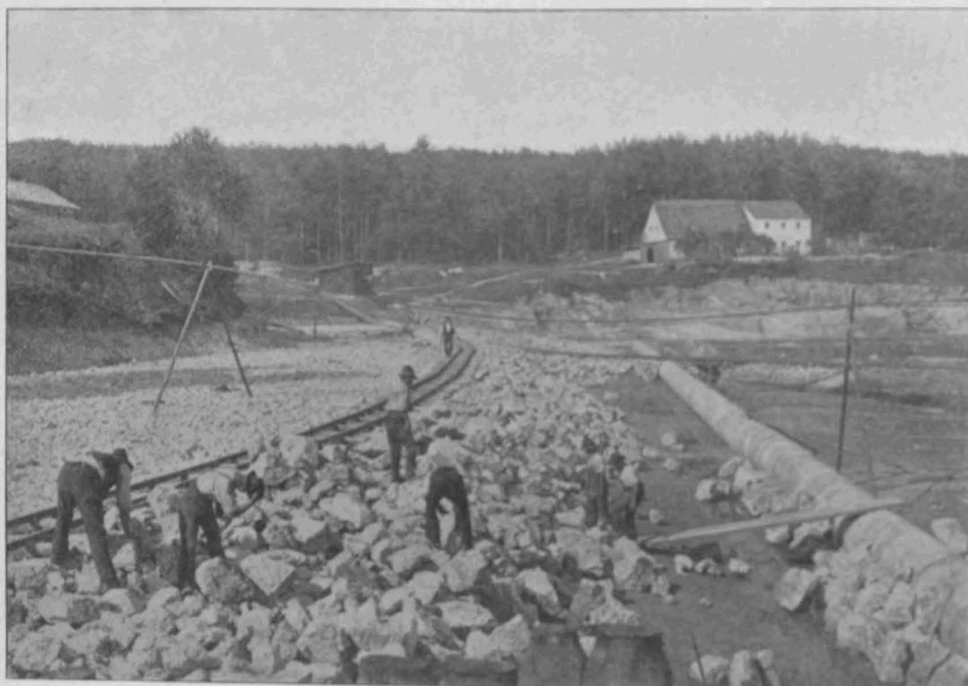
Abbildung 12. Quellfassung bei Ranna. Ausfüllung des Quellfassungsbeckens mit Dolomit-Steinen.
