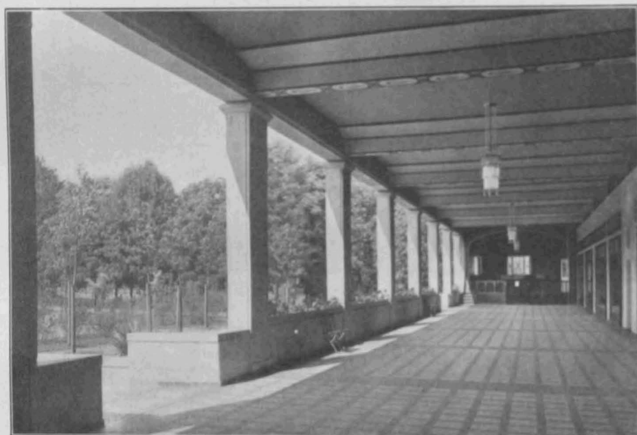
Innenansicht der Wandelhalle.
