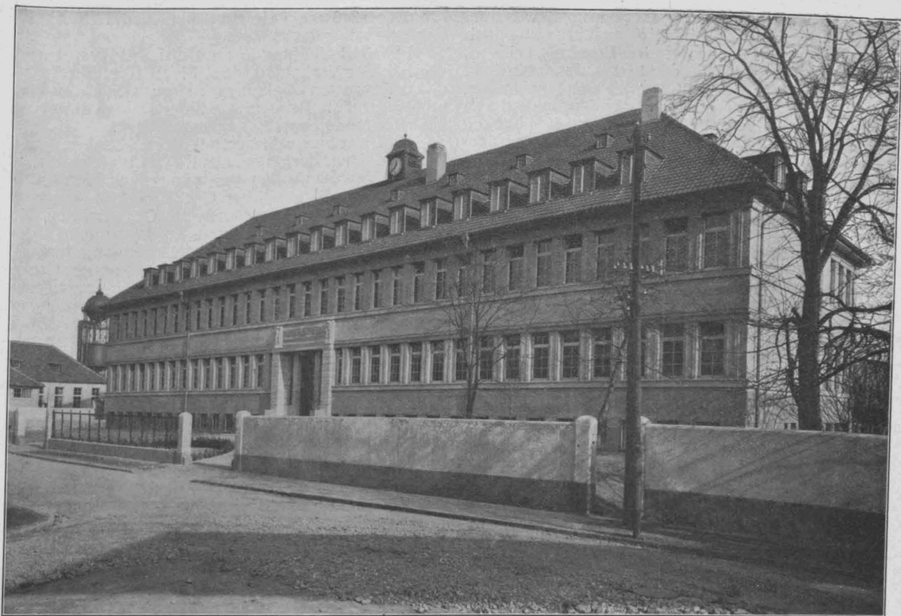
Bürogebäude der Mannstaedtwerke, Façonwalzwerk in Troisdorf bei Köln. Architekten: Schreiterer & Below in Köln.
