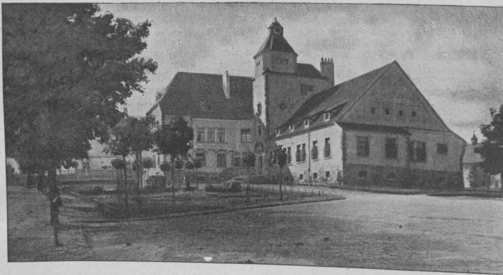
Verwaltungsbau von Norden.
