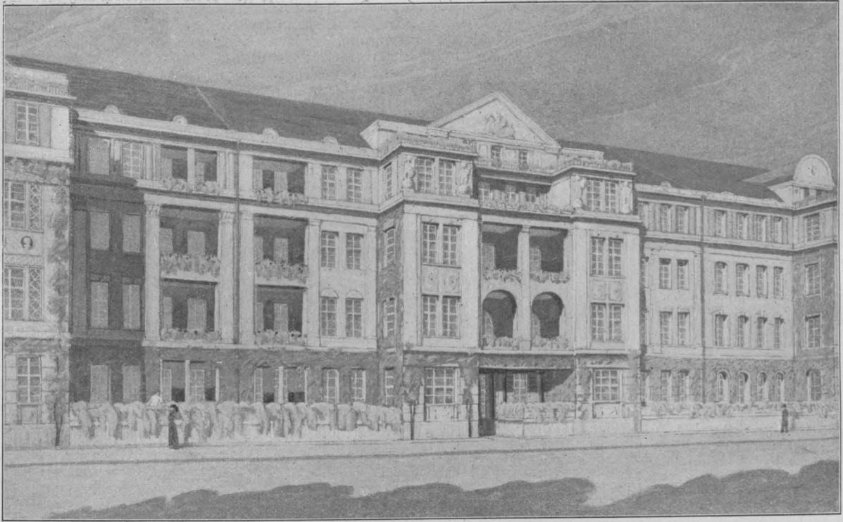
Häusergruppe an der Westseite des Platzes L mit einheitlicher Berandung und Bepflanzung der Balkon-Terrassen im Erdgeschoß.
