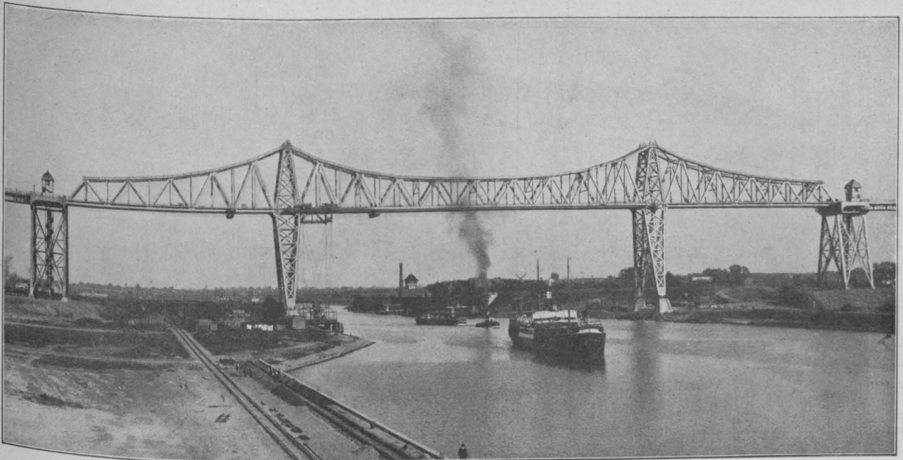
Abbildung 4. Eisenbahn-Hochbrücke bei Rendsburg nach Vollendung. Photogr. Aufn. von J. Leschen in Rendsburg.
