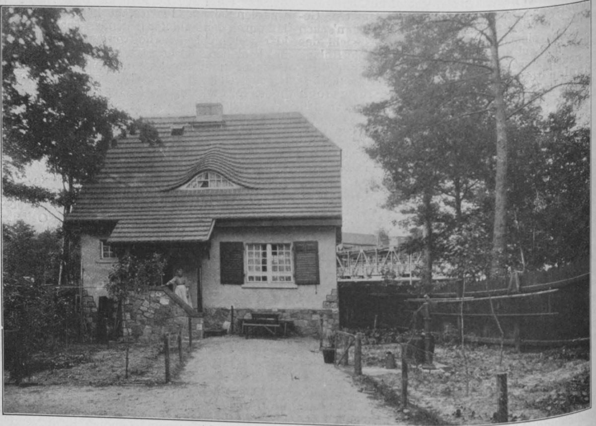
Abbildung 25. Brückenwärter-Gehöft an der Pechteicher Wassertorbrücke.
