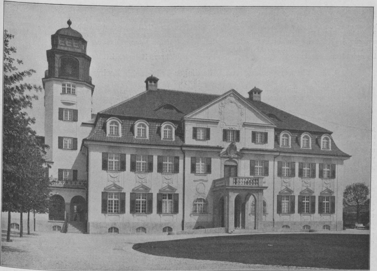
Ansicht mit Vorfahrt, Westseite.
