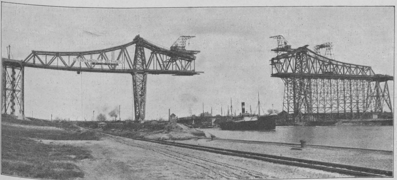
Abb. 9. Eisenbahn-Hochbrücke bei Rendsburg. Freimontage der Mittelöffnung, festes Gerüst der Seitenöffnung der Kanalbrücke.
