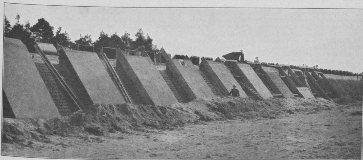
Abbildung 29. Herstellung einer 0,35 m starken Betonverkleidung auf Tonschicht für die städt. Liegestellen bei Eberswalde.
