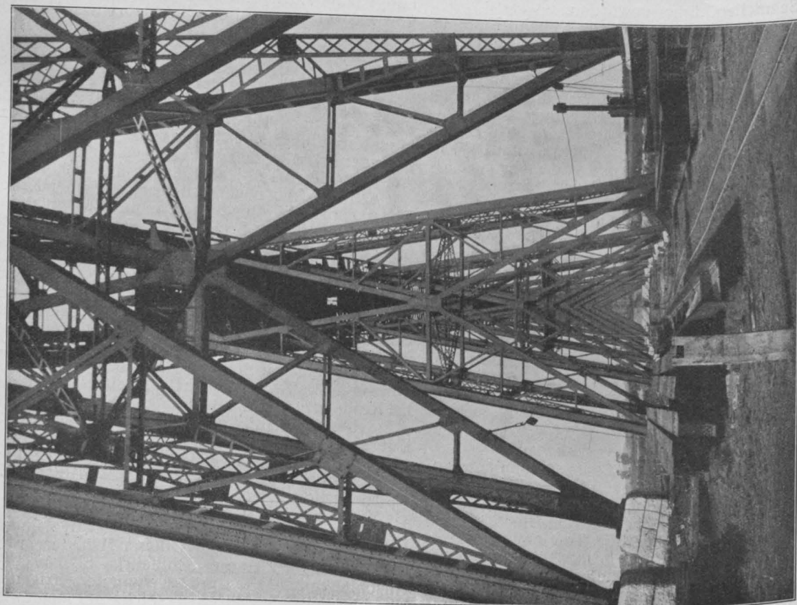
Abbildung 5. Blick in den Viadukt-Unterbau. Eisenbahn-Hochbrücke bei Rendsburg. Photographische Aufnahme von J. Leschen in Rendsburg.
