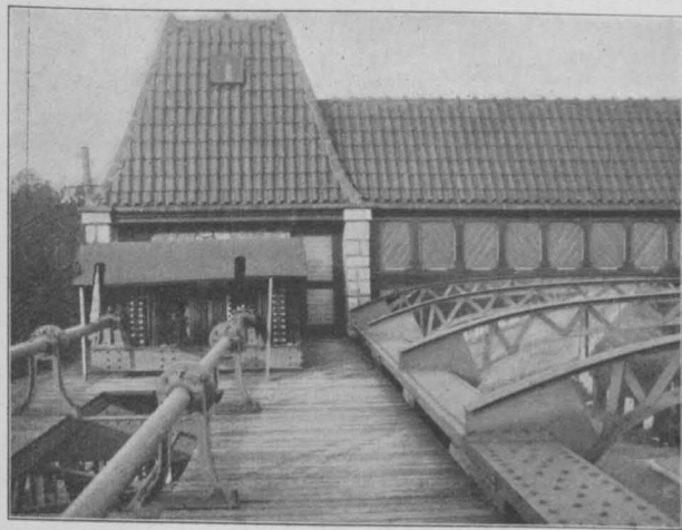
Abbildung 23. Blick in das Getriebe für die Torbewegung.
