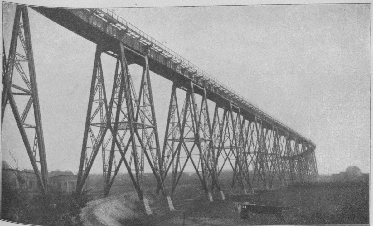
Abbildung 8. Teilstrecke des fertigen Eisen-Viaduktes der Eisenbahn-Hochbrücke bei Rendsburg.
