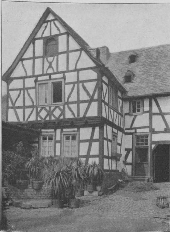
Altes Fachwerkhaus in Leubsdorf bei Linz a. Rh. Phot. Aufnahmen von Frans Huysser in Godesberg a. Rh.
