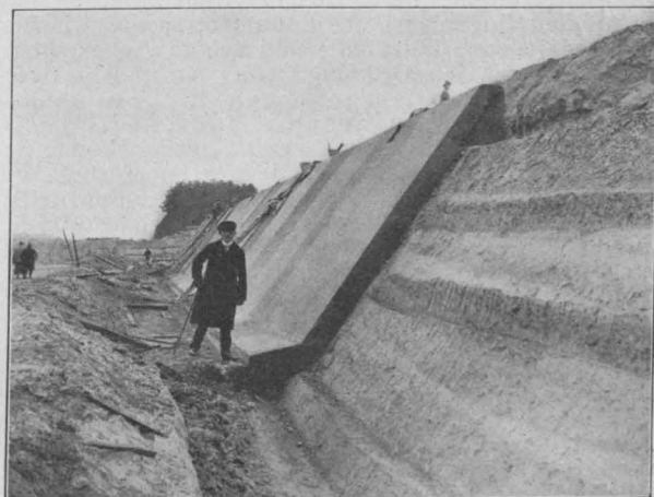
Abbildung 30. Herstellung der Betondeckung der Liegestelle am Kaiserweg.
