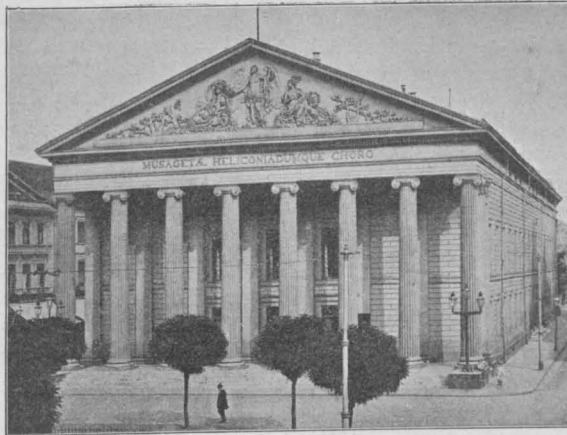
Gegenwärtiger Zustand des Theaters.
