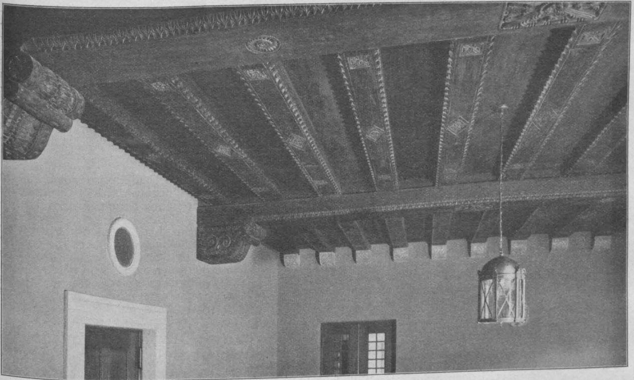
Decke des Vorsaales im ersten Obergeschoß.
