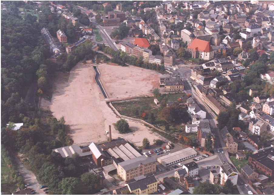
Abb. 122 Gelände der ehem. Firma 'Georg Schleber AG' nach dem Abriss, 2000
