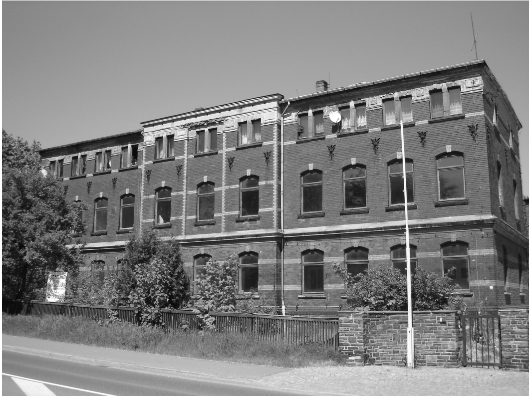
Abb. 38 Fabrik der ehem. Firma 'Johann Friedrich Beck' in Reichenbach im Vogtl. 2010
