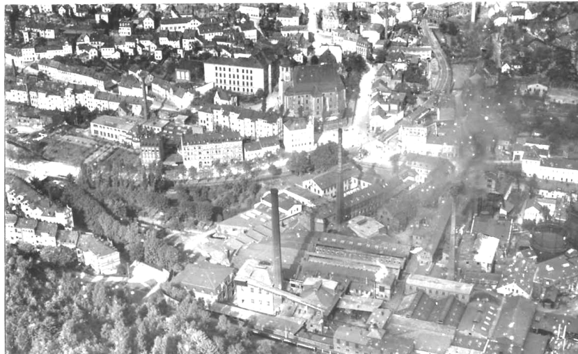
Abb. 120 ‘Georg Schleber AG’, Blick nach Norden
