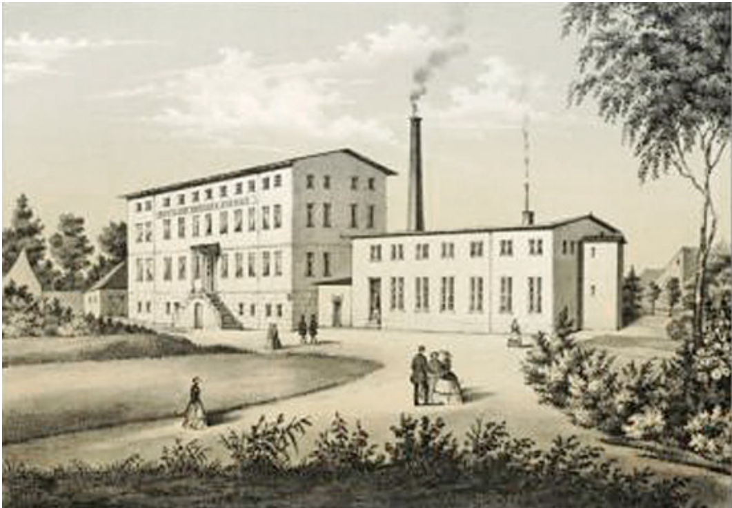
Abb. 93 Strumpffabrik der Firma 'Gottlieb Hecker u. Söhne' in Chemnitz
