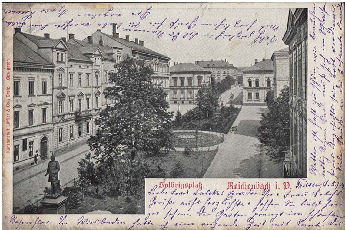
Abb. 61 Solbrigplatz in Reichenbach im Vogtl., Blick nach Nord-Westen
