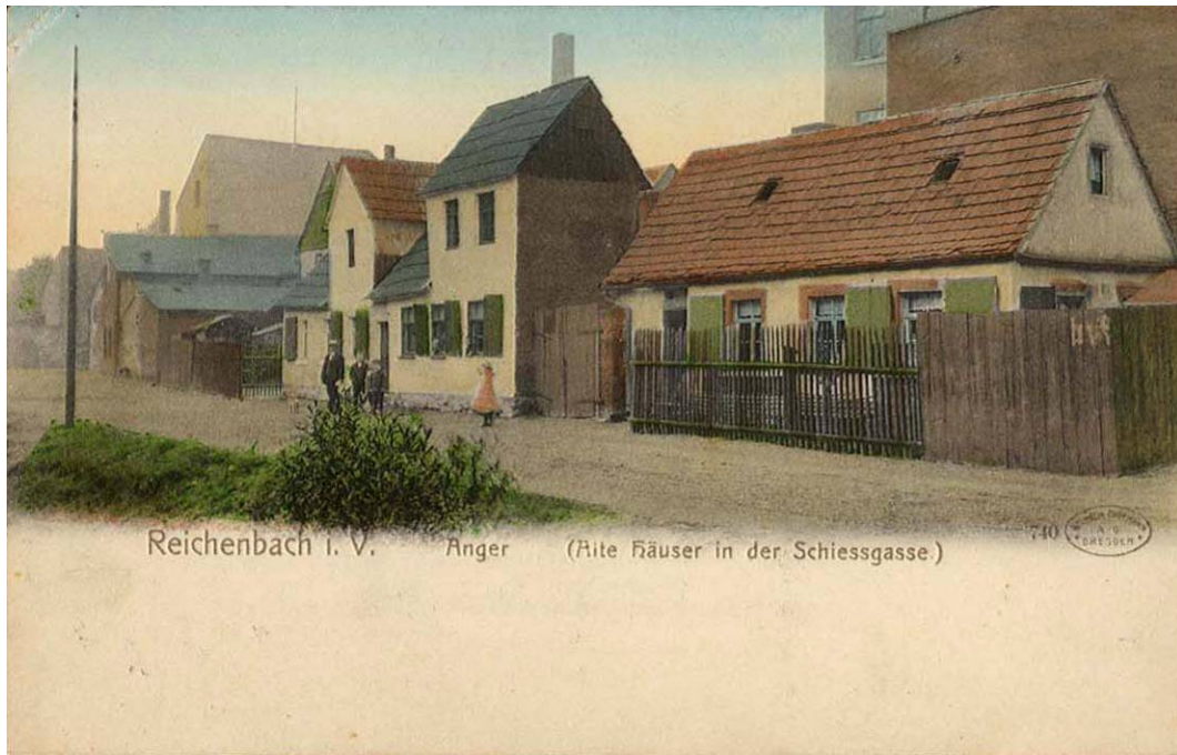
Abb. 203 Anger, alte Häuser in der Schiessgasse in Reichenbach im Vogtl.
