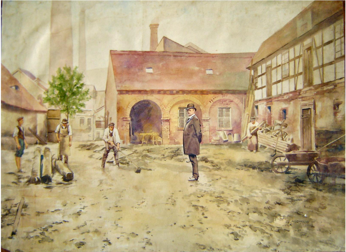
Abb. 117 der Hof von Schlebers Fabrik nach dem Hochwasser vom 3.4. Juni 1889
