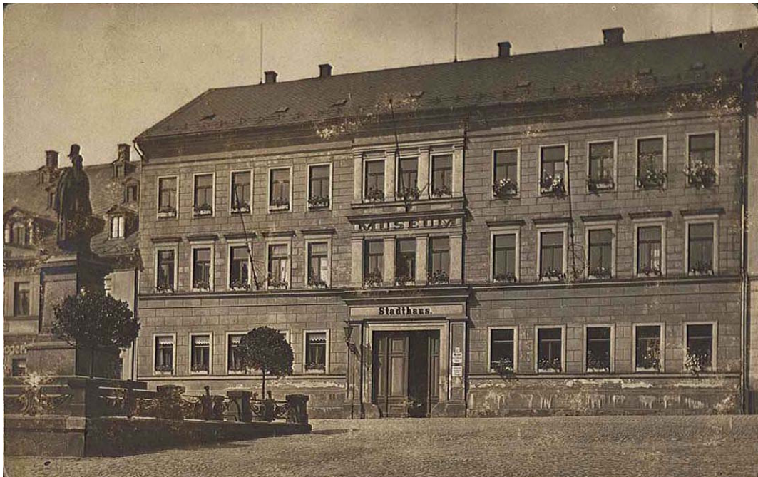
Abb. 198 Stadthaus auf dem Marktplatz Reichenbach im Vogtl, nach 1904
