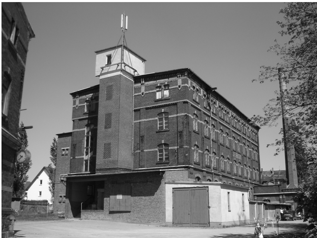
Abb. 39 Fabrik der ehem. Firma 'Johann Friedrich Beck' in Reichenbach im Vogtl. 2010
