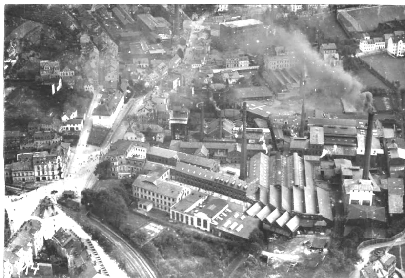
Abb. 121 ‘Georg Schleber AG’, Blick nach Osten
