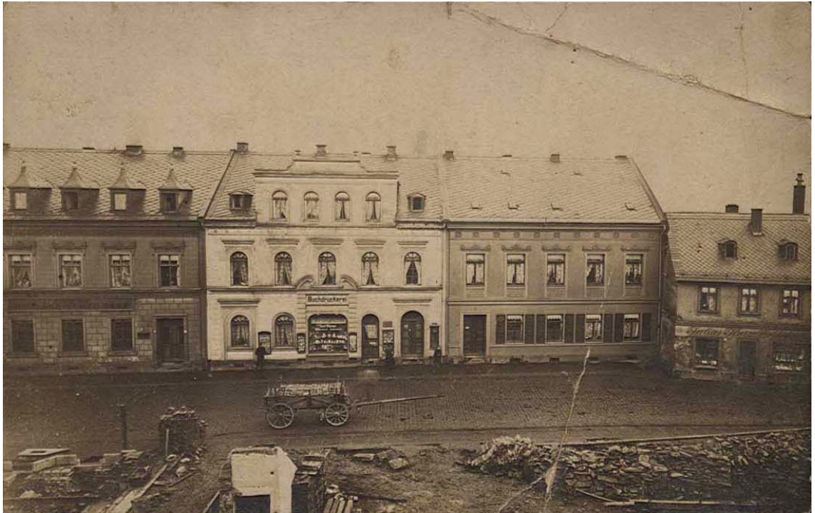
Abb. 180 Bahnhofstraße in Reichenbach im Vogtl., um 1908
