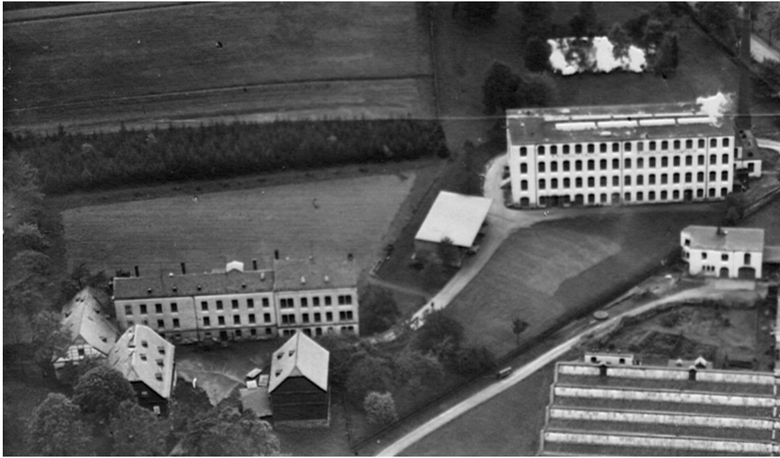
Abb. 47 Fabrikgebäude der Firma 'Robert Tröltzsch & Sohn' in Reichenbach im Vogtl. Links befindet sich das Sorgengut, rechts die 1885 errichtete Fabrik.
