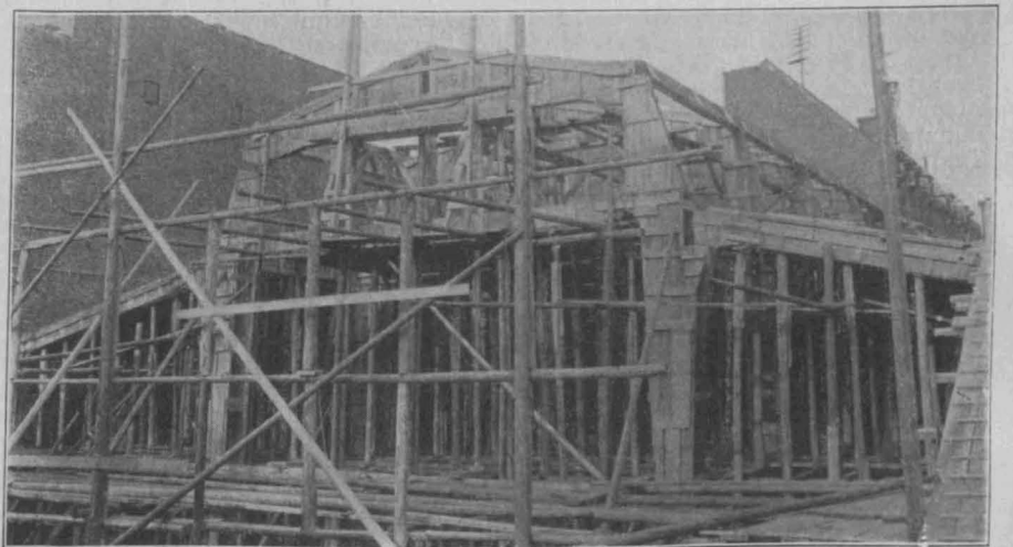
Abbildung 8. Wagenhalle während der Ausführung.
