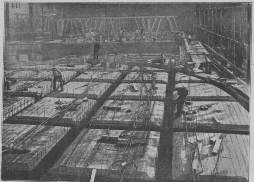
Abbildung 2. Verlegung der Rippeneisen in der eingeschalteten Decke.
