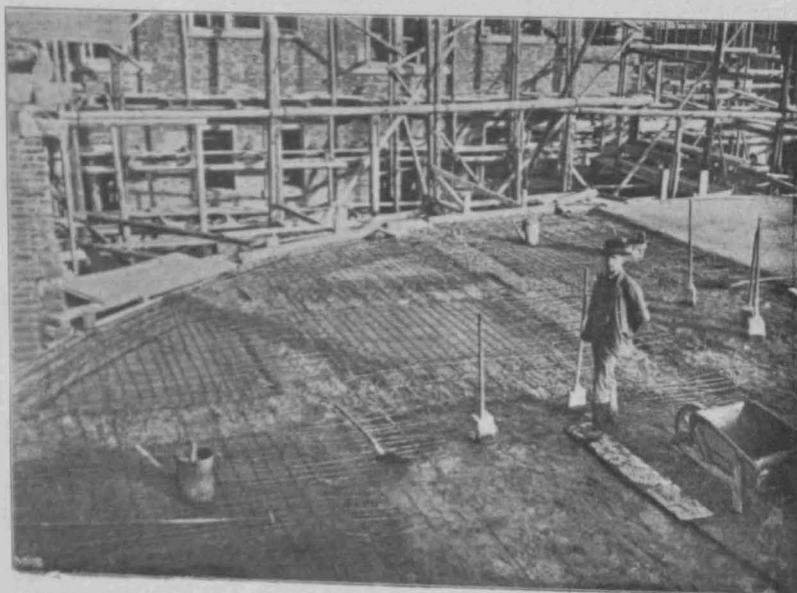
Abbildung 3. Decke während der Herstellung. Einbetonieren der Deckenplatte.
