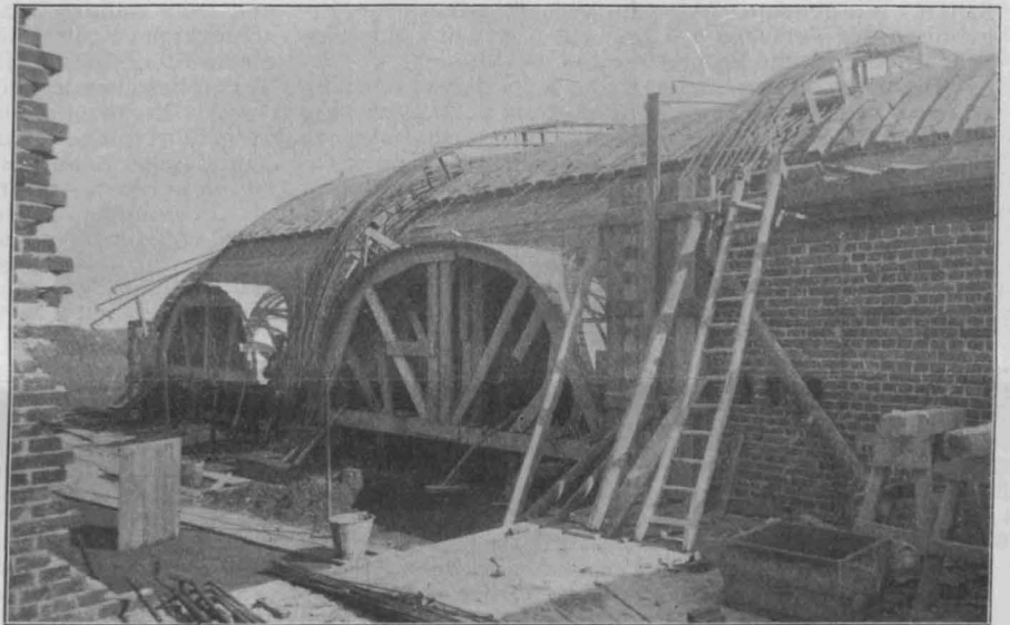
Abbildung 8. Herstellung des Gewölbes.
