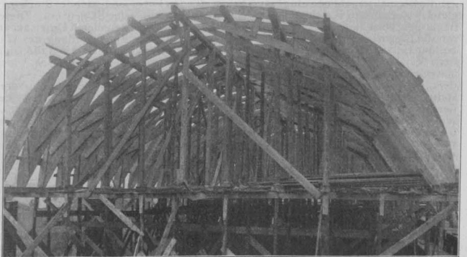
Abbildung 7. Lehrgerüst des Aula-Gewölbes.
