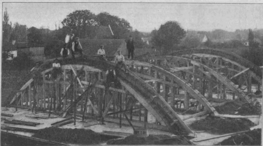
Abbildgn. 2 und 3. Dachstuhl während der Ausführung und vor Einschaltung des Daches
