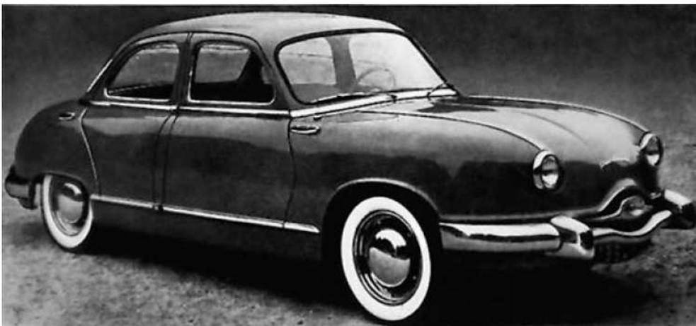
**Bild 3: Dyna Panhard 1954 mit selbsttragender Karosserie aus Aluminium**
