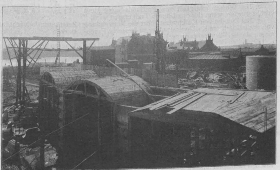
Abbildung 7. Ausführung des Eisenbeton-Unterbaues.
