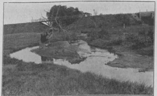
Abbildung 7. Zustand des Marbaches (des Hauptsammlers von Bochum) vor Beginn der Arbeiten.
