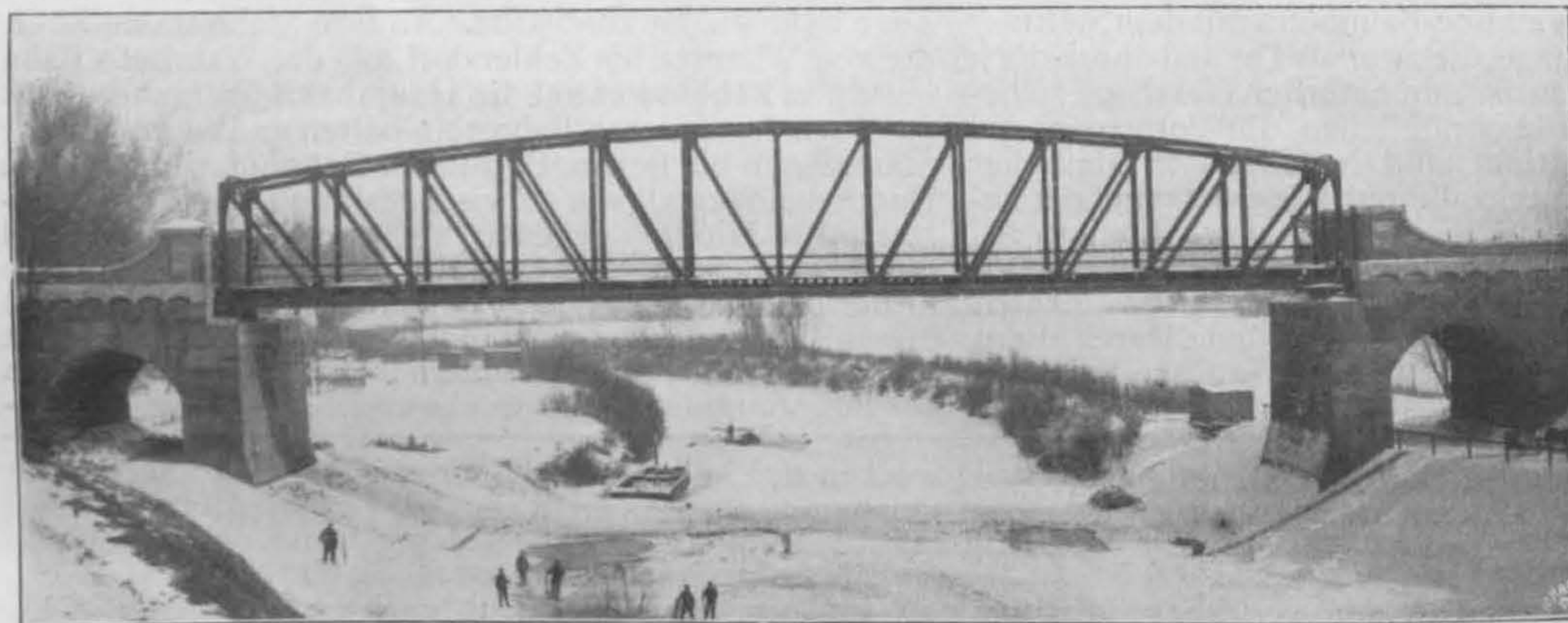
Abbildung 6. Fertiges neues Brückenbauwerk.
