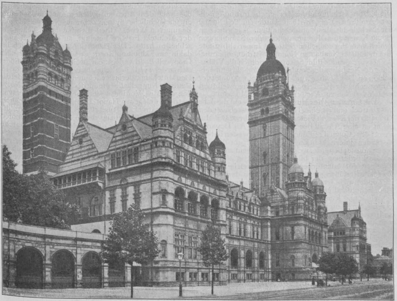
Das kaiserliche Institut und die Universität zu London-Kensington. Architekt: Th. E. Collcutt.
