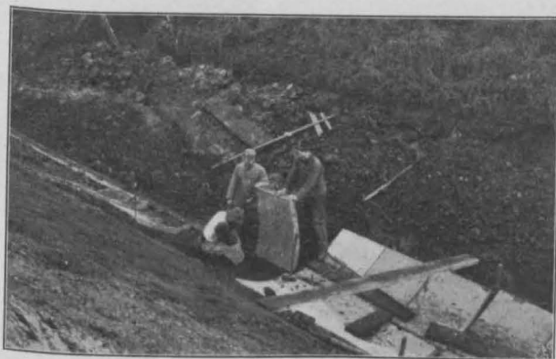
Abbildung 6. Einbringen von Betonplatten in der Berne bei Essen.
