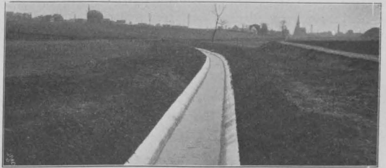
Abbildung 10. Fertiger Marbach auf freier Strecke.
