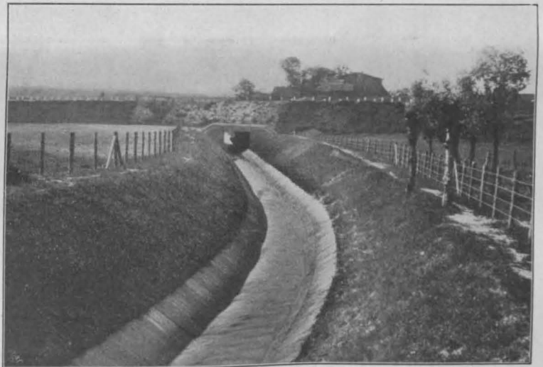
Abbildung 8. Zustand der Marbachstrecke (Abbildung 7) nach Vertiefung um 2,5 m, Geradelegung und Befestigung mit Betonplatten.
