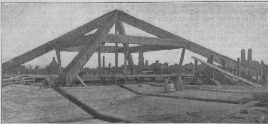
Abbildg. 21. Zeltdach über den Eckpavillons während der Ausführung.
