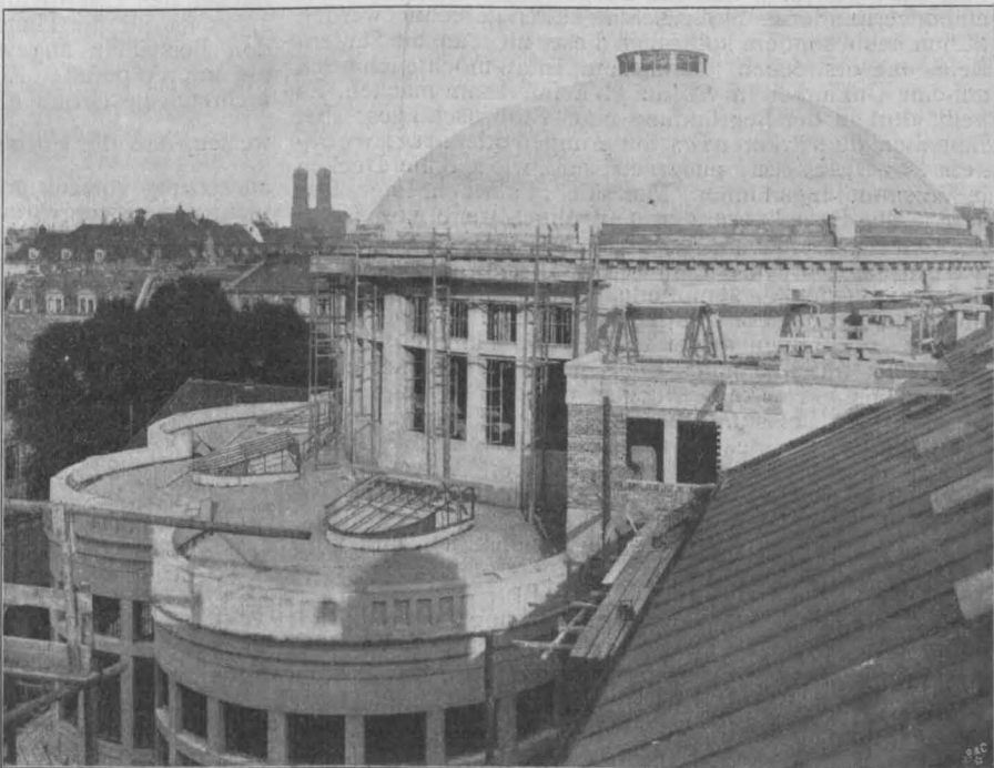
Abbildg. 24. Kuppel und nördlicher Vorbau nach der Ausschalung.
