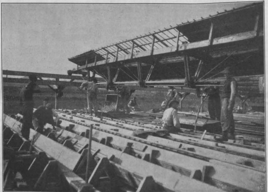
Abbildg. 6. Einstampfung liegender Eisenbetonpfähle.
