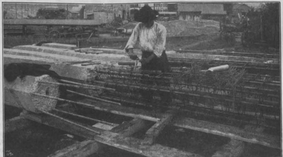
Abbildg. 7. Verlängerung von Eisenbetonpfählen.
