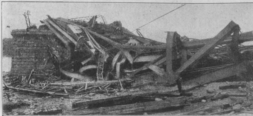
Abbildg. 5. Trümmer des eingestürzten Ankerarmes. Blick vom Ufer nach dem Strompfeiler.
