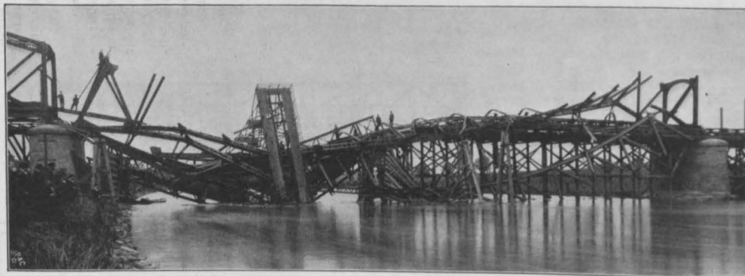
Abbildung 40. Während der Montage am 2. Oktober 1905 eingestürzter eiserner Ueberbau.
