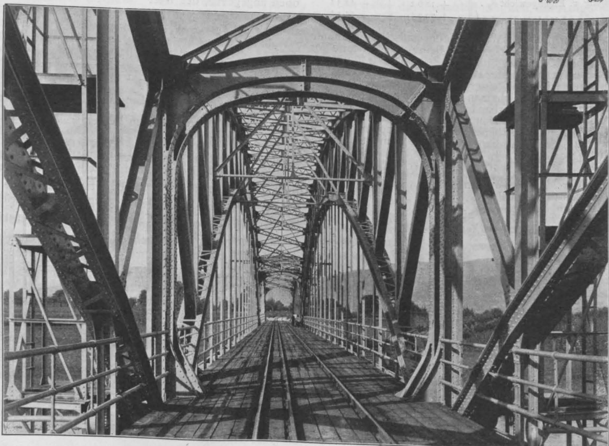
Abbildg. 16. Einblick in die Brücke.
