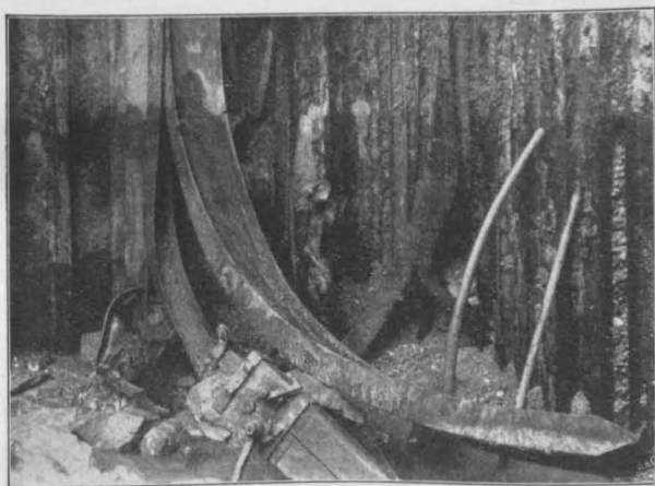
Abbildg. 12. Zustand der eingerammten Spundwand in Baugrube IV.
