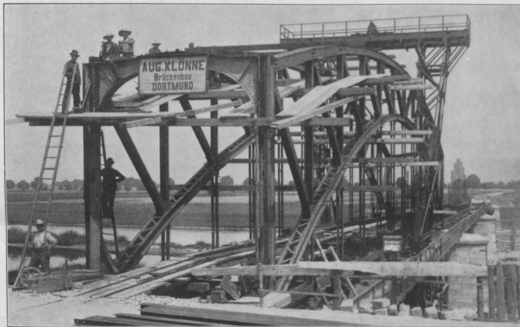
Abbildung 39. Einbau des Obergerüsts zum Vernieten des Ueberbaues der Öffnung 1. Juli 1905.
