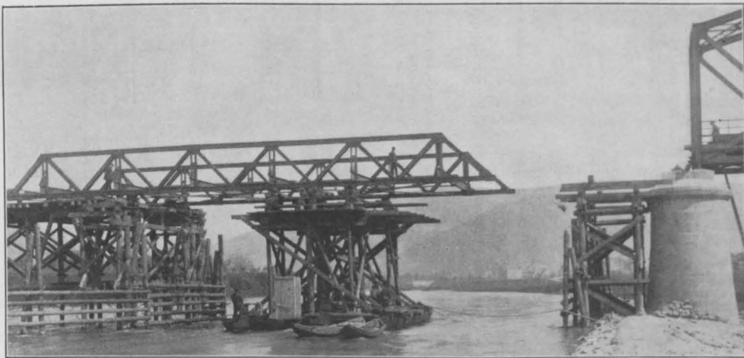
Abbildung 38. Ueberfahren des Hilfsträgers über die Schiffsöffnungsöffnung bei der zweiten Montage 1906.
