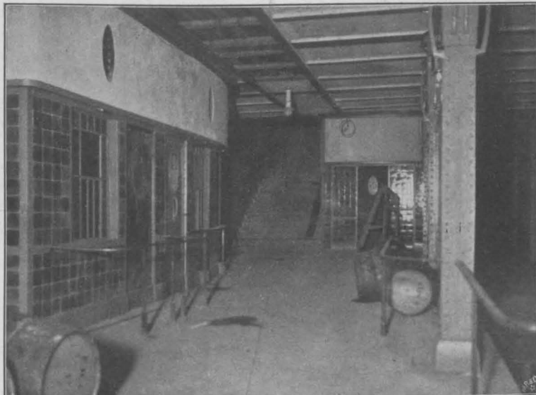
Abbildg. 14. Blick auf die Eingangstreppe und die Fahrkartenausgabe.
