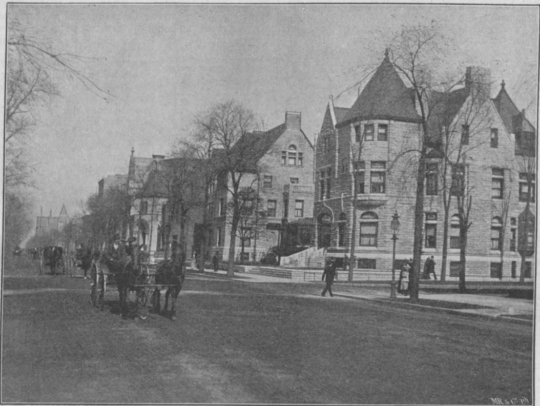
Abbildg. 6. Blick in eine Wohnstrasse zu Chicago.
