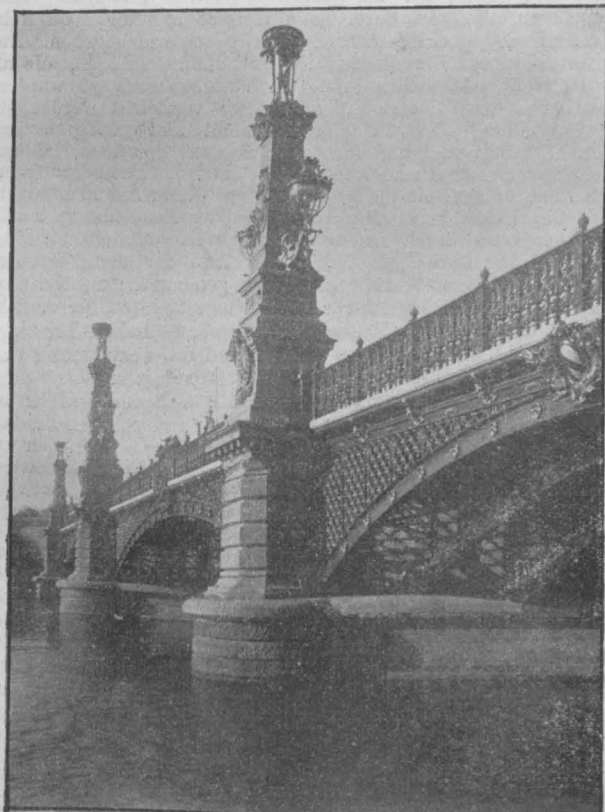
Universitätsbrücke in Strassburg. Arch. Stadtrth. Ott.
