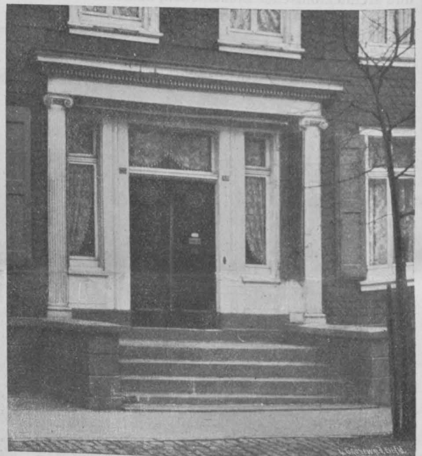
Abbildg. 8. Barmen, Allee-Strasse 30.
