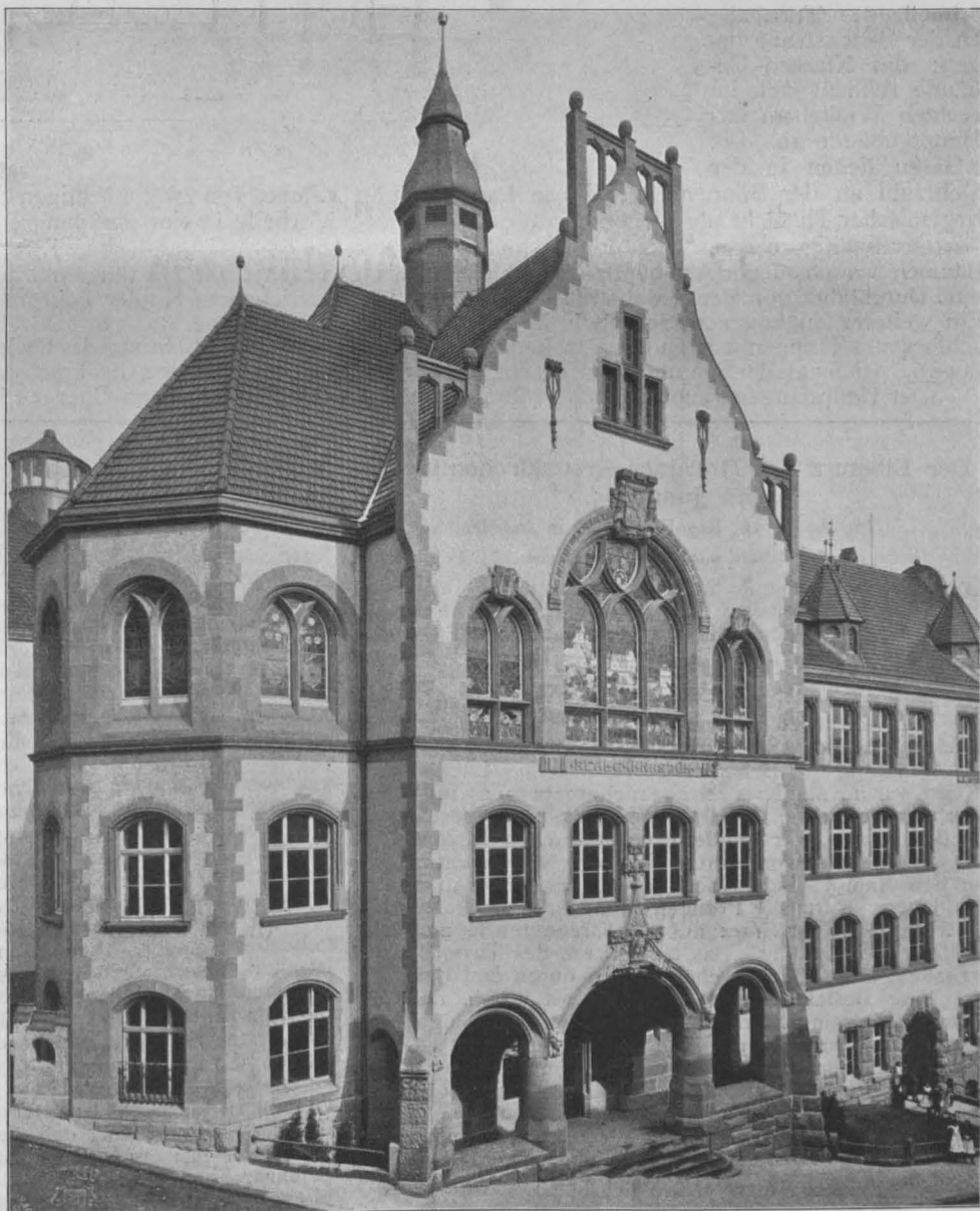
Nordwest-Ecke mit dem Haupteingang.
