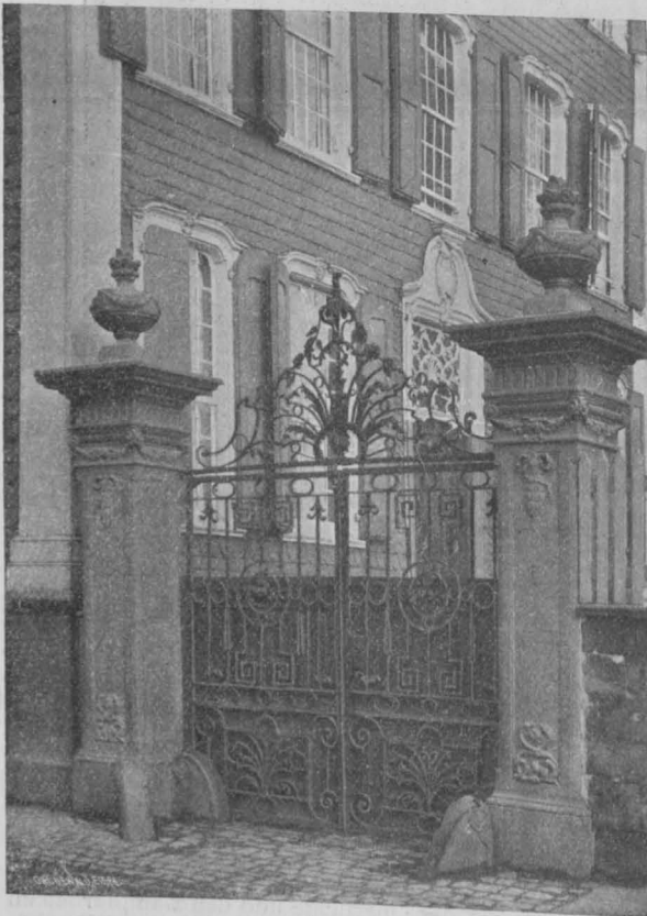
Abbildg. 6. Barmen, Schafbrücken-Strasse.
