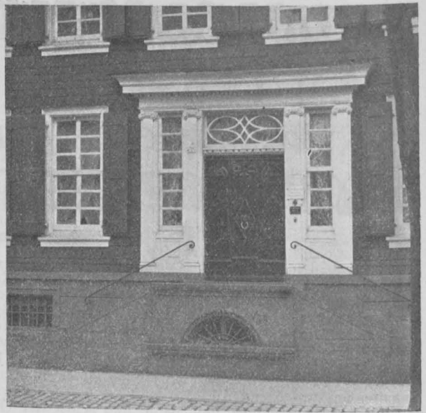
Abbildg. 7. Barmen, Allee-Strasse 160.
