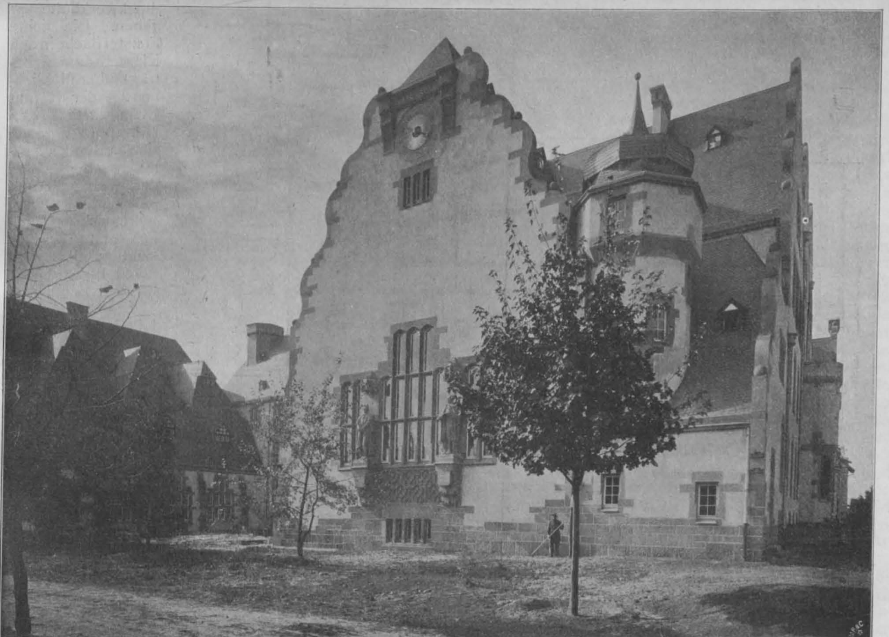
Ansicht an der Ahornstraße (Ecke Burggrafenstraße).
