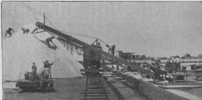
Abbildg. 22 u. 23. Salz-Transportband mit fahbarem Motor.
