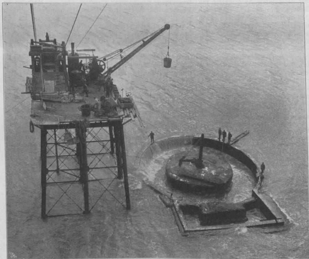
Abbildg. 2. Unteres Ende der Drahtseilbahn. Arbeitsgerüst an der Baustelle.
