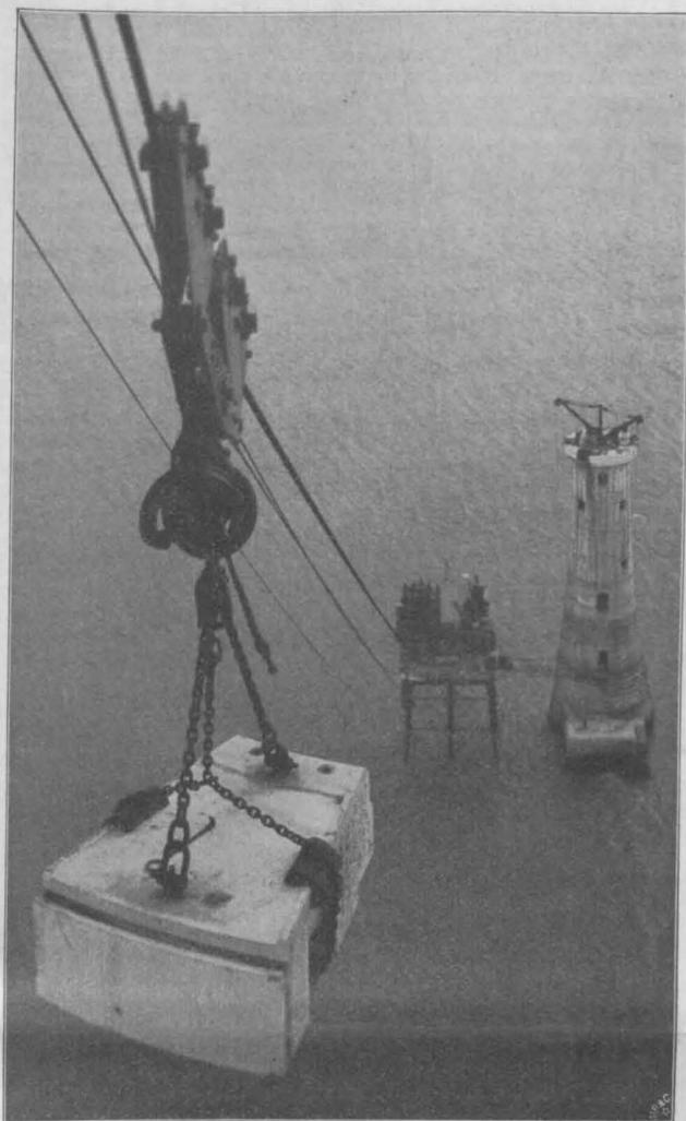
Abbildg. 3. Laufkatze zum Transport von Werkstücken.
