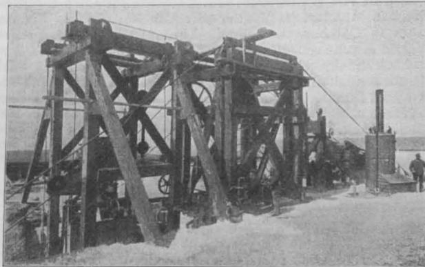
Abbildg. 4. Oberes Ende der Drahtseilbahn mit der Bremsvorrichtung.
