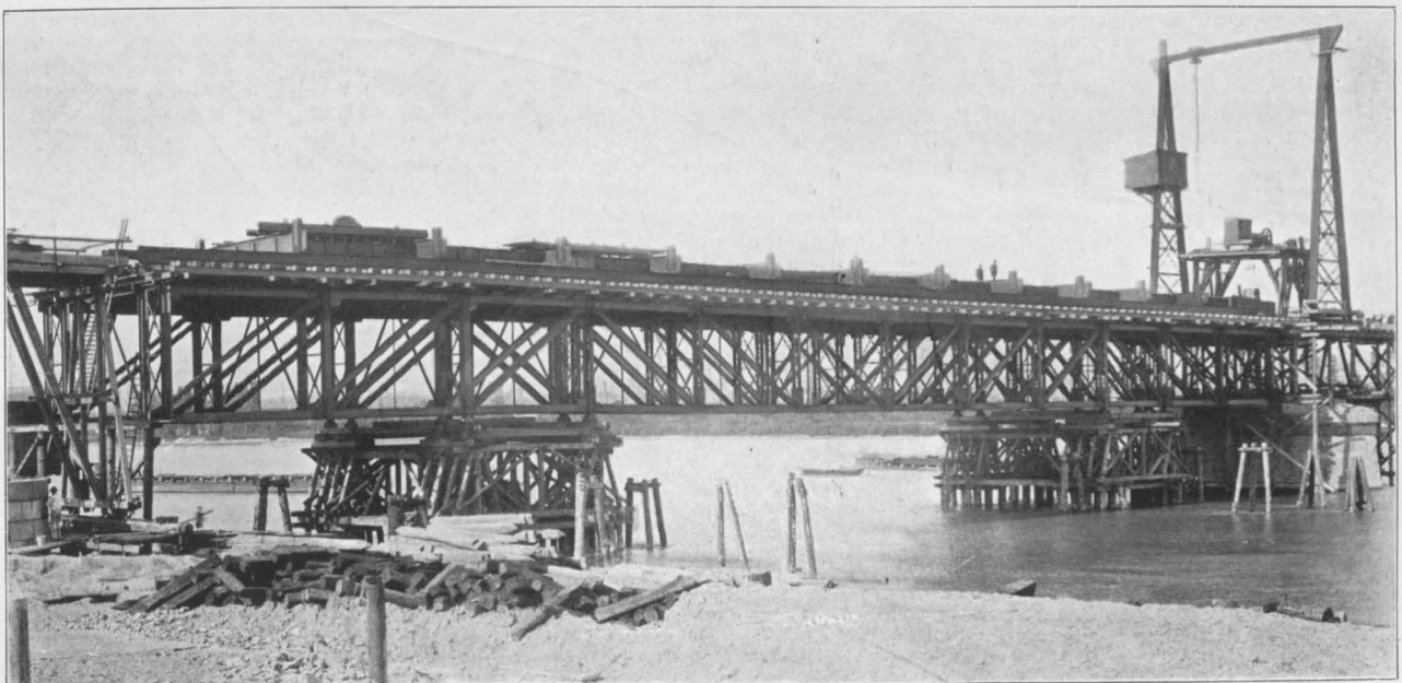
D IE NEUE EISENBAHN-VERBINDUNG ÜBER DEN RHEIN BEI MAINZ * DIE RHEINBRÜCKE WÄHREND DER MONTAGE * GESAMT-ENTWURF: EISENBAHN-DIREKTION MAINZ; EINZEL-ENTWURF UND AUSFÜHRUNG: BRÜCKENBAUANSTALT GUSTAVSBURG BEI MAINZ * * ≡ DEUTSCHE BAUZEITUNG XXXVIII. JAHRG. 1904 N o . 35 ≡
