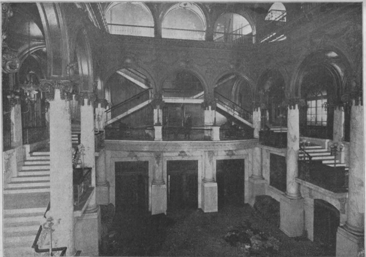
Abbildg. 6. Treppenhalle von dem Randolph-Strassen-Eingang gesehen.
