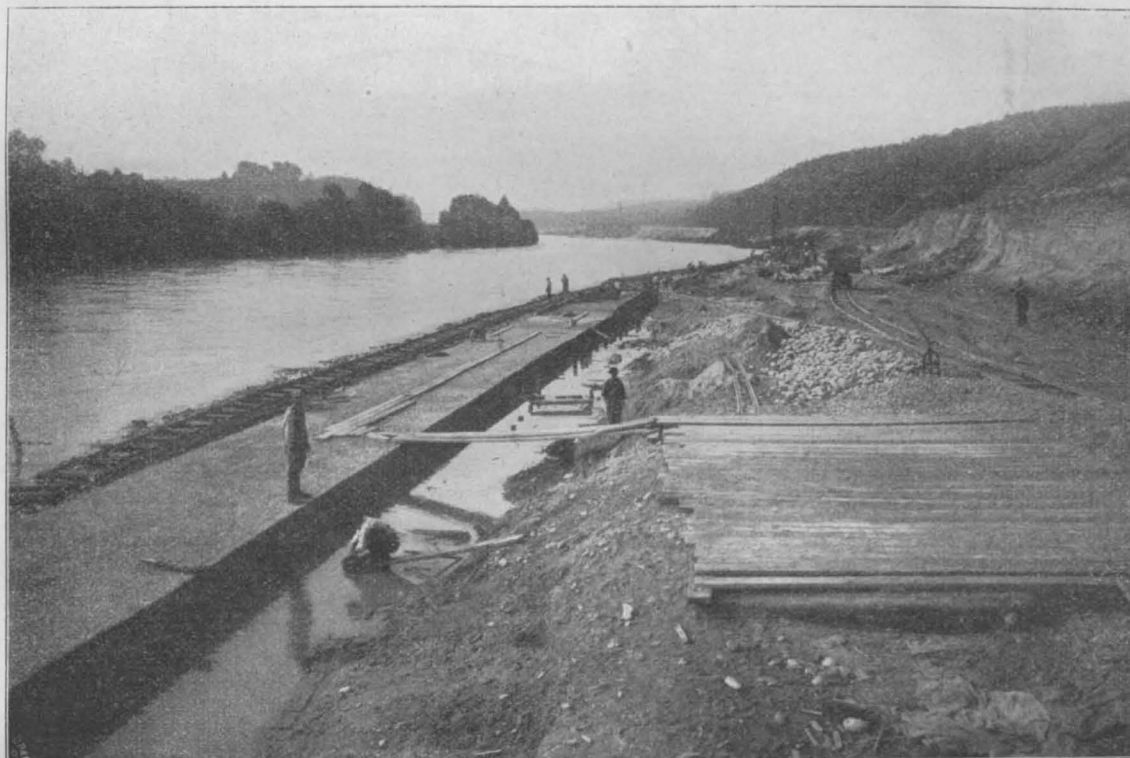
Abbildg. 8. Ober-Wasser-Kanal am Fahrhöfl mit Ufermauer-Fundament. (Aufnahme vom 27. September 1901.)
