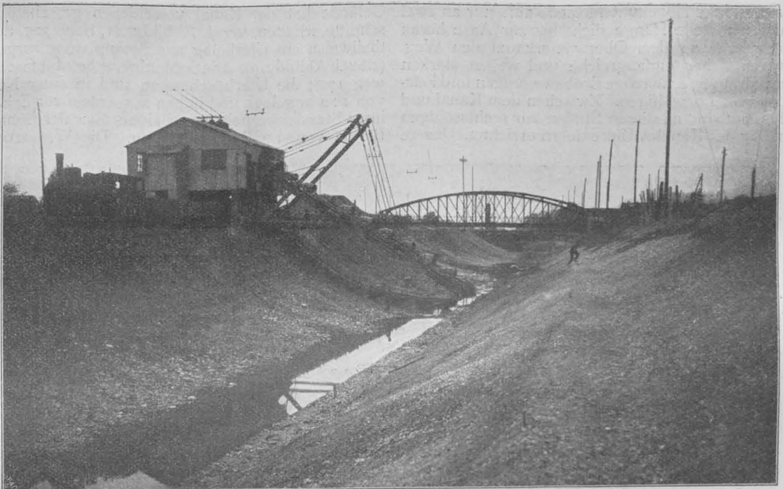
Abbildg. 10. Ober-Wasser-Kanal mit elektrisch angetriebenem Bagger. (Aufnahme vom 30. April 1902.)
