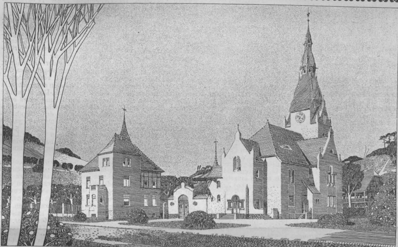
Kirche der „Los von Rom“-Bewegung und Pfarrhaus in Langenau in Böhmen 1902. Arch.: Schilling & Gräbner in Dresden.
