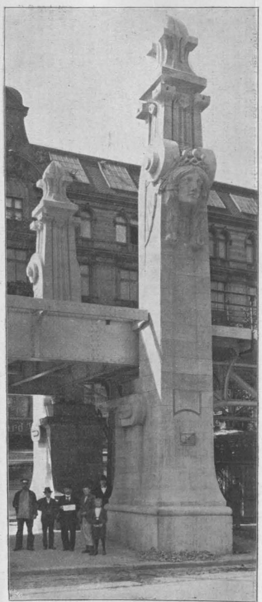
PFEILER AN DER POTSDAMER STR. ARCHIT.: BRUNO MÖHRING ****
