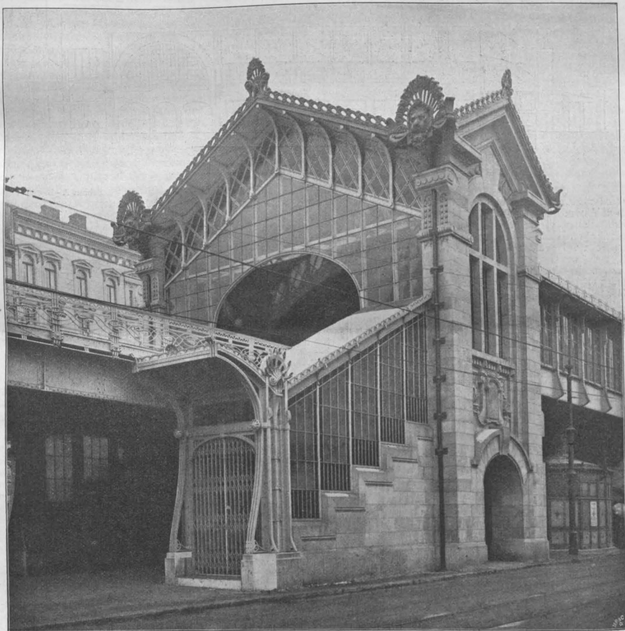
Bahnhof „Bülowstrasse“. Architekt: Bruno Möhring in Berlin.
