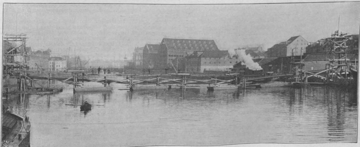
Der Pregel in der Nähe der Eisenbahnbrücke in Königsberg i. Pr.
