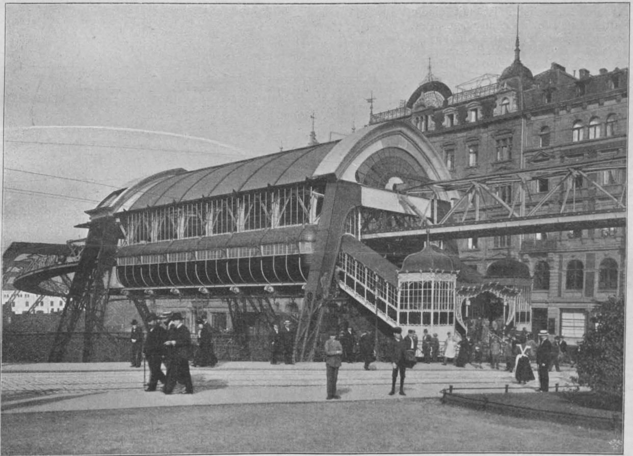
Abbildg. 17. Bahnhof Döppersberg.
