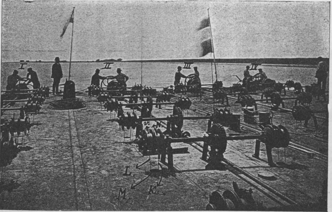
Fig. 4. Vermittels der Winden I, II, III und IV wird das Sinkstück unter den Pramm herangezogen.
