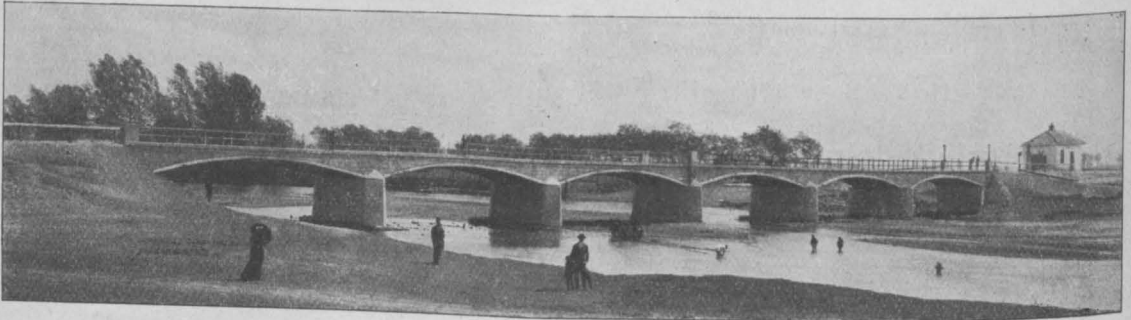
Fig. 1. Neutrabrücke in Neuhäusel. 6 Öffnungen mit 17 m Sichtweite. Erbaut 1892.
