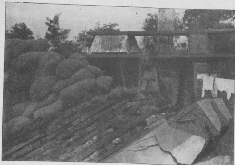
Fig. 12. Bruch des Probeobjektes III.
