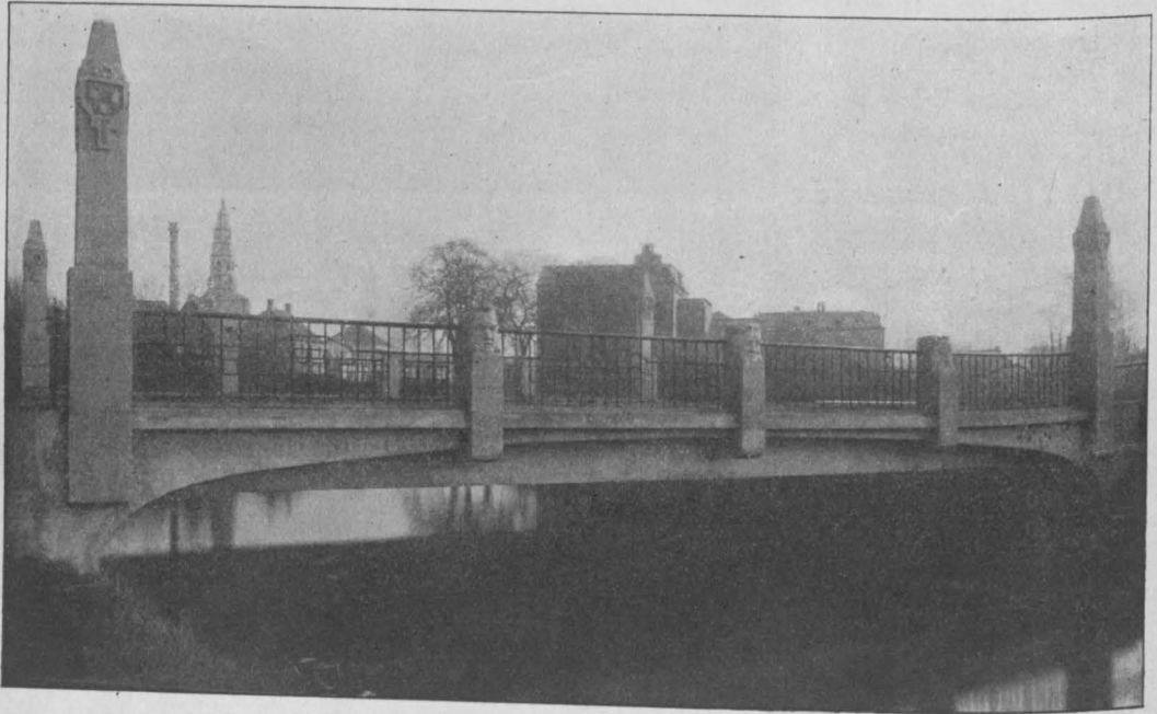
Fig. 8. Ansicht der Brücke.
