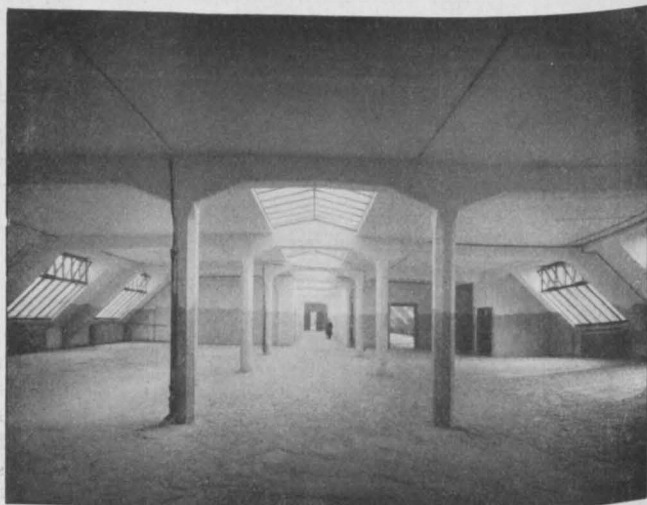
Fig. 7. Blick in den Dachraum.
